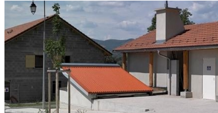
Chaufferie bois La Rivière (38)
