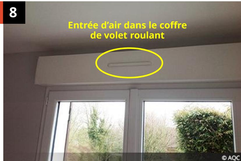
Bouche d'entrée d'air positionnée en applique sur le coffre de volet roulant.
