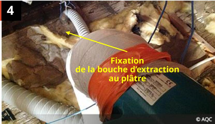
Raccordement des gaines de ventilation
