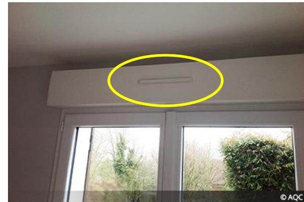
Entrée d'air positionnée en applique sur le coffre de volet roulant
