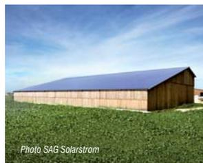
Les toitures photovoltaïques intégrées des hangars agricoles et d'élevage sont traitées en détail au moment de la conception pour tenir compte des conditions ambiantes à l'intérieur du hangar, notamment de la présence d'une atmosphère corrosive.
