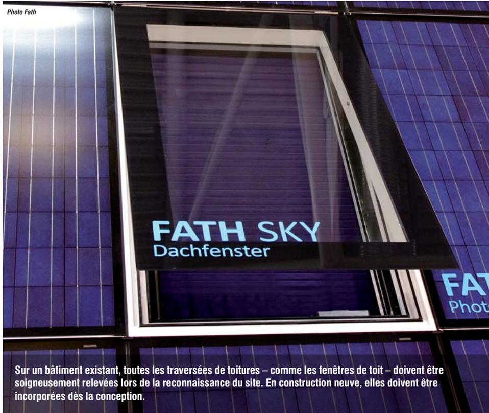
Sur un bâtiment existant, toutes les traversées de toitures – comme les fenêtres de toit – doivent être soigneusement relevées lors de la reconnaissance du site. En construction neuve, elles doivent être incorporées dès la conception.
