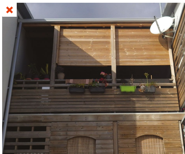
Pour se protéger du soleil, les usagers ont ajouté des éléments en bois ayant une classe d'usage non adaptée pour l'extérieur. La fixation des lames directement sur les montants en bois crée également un point singulier favorisant la stagnation de l'humidité et la dégradation de ces éléments structuraux. ©AQC
