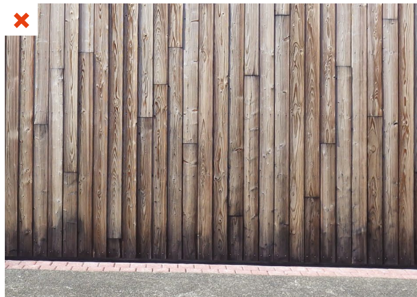
Apparition de champignons en pied de bardage soumis au rejaillissement de l'eau de pluie. ©AQC
