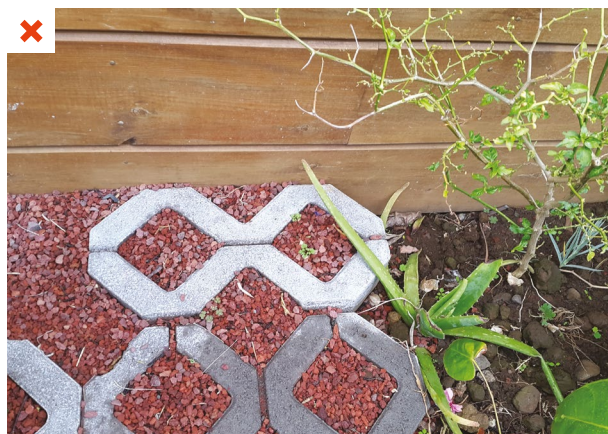
Les occupants du logement ont réalisé des aménagements paysagés aux abords du bâtiment. La garde au sol du bardage bois n'existe plus. ©AQC
