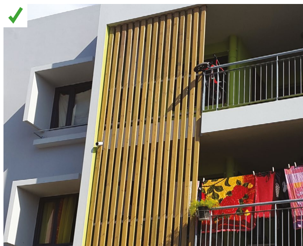
Le brise-soleil en bois est intégré au bâtiment et en léger retrait à l'intérieur du plan de façade. Les extrémités des pièces de bois se retrouvent ainsi protégées par l'acrotère. ©AQC
