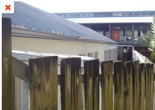
Absence de protection des coupes d'arase horizontales (bois de bout) favorisant l'apparition de champignons sur le bois. ©AQC
