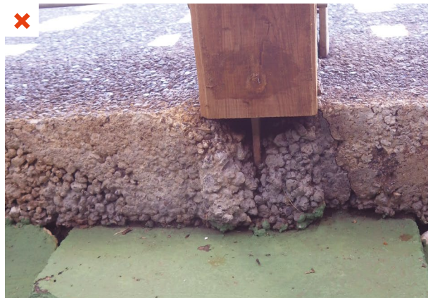
Ajout d'un béton de revêtement de sol dans l'épaisseur de la platine qui assurait la garde à l'eau du poteau en bois. Le bois, directement en contact avec l'eau ruisselant sur le sol, subit des remontées capillaires.
