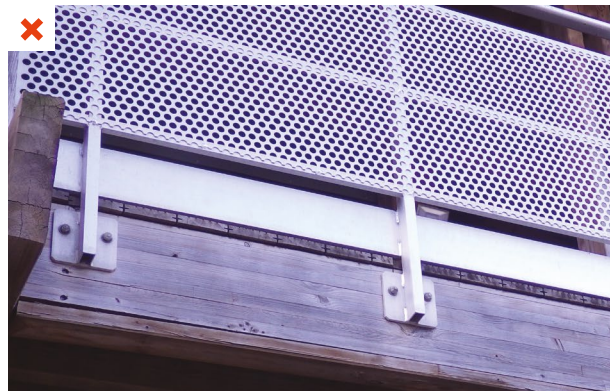
Délamination du BLC exposé aux intempéries. ©AQC
