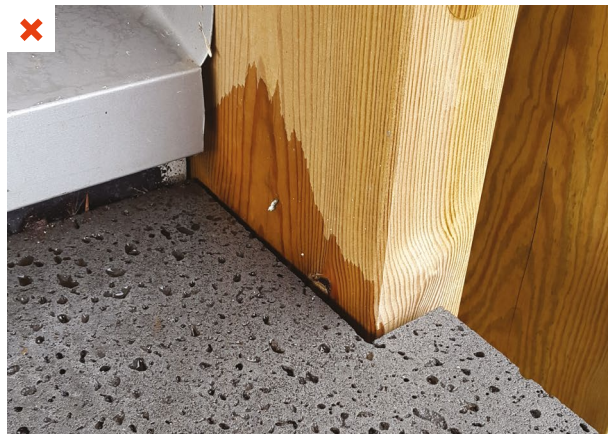
Rejaillissement de l'eau depuis l'appui de fenêtre vers l'encadrement en bois. ©AQC
