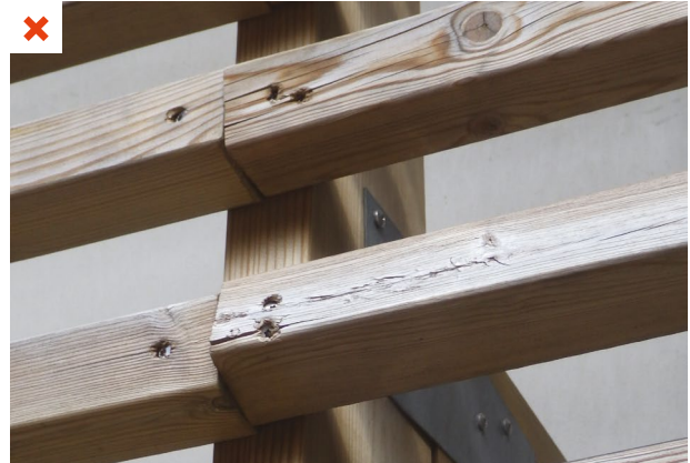
Le mode de fixation de ces tasseaux en pin sylvestre C4 est inadapté pour reprendre les efforts de torsion de ces derniers. ©AQC
