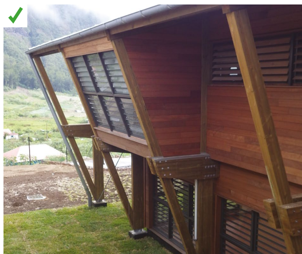
Débords de toits importants limitant l'impact de la pluie sur les bardages en bois. L'inclinaison des façades les moins protégées par les débords de toiture limite le ruissellement de l'eau sur le bardage. ©AQC
