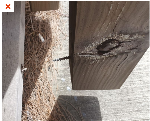
Section de l'ossature insuffisante pour permettre une longueur d'ancrage des fixations respectant le DTU. Revêtements extérieurs en bois. ©AQC
