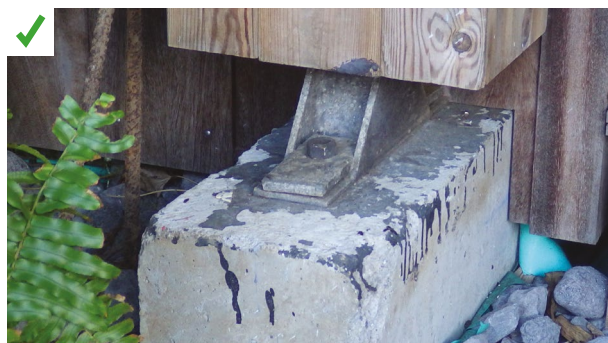
Mise en place d'une barrière physique anti-termites (film polyane vert sur la photo) entre le sol et le bâtiment limitant la propagation des termites. ©AQC
