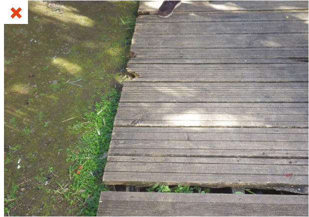
Pourrissement prématuré d'un platelage bois, traité pour un usage en classe 4, soumis à des conditions d'humidité importantes. ©AQC
