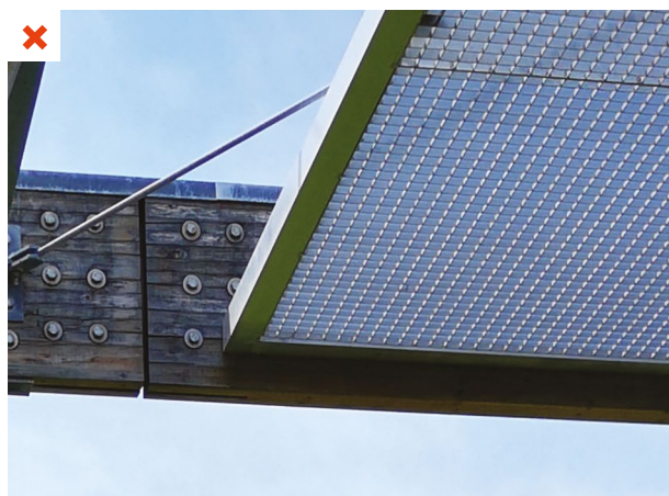
Présence de gerces de dessiccation sur du BLC exposé aux contraintes climatiques. ©AQC
