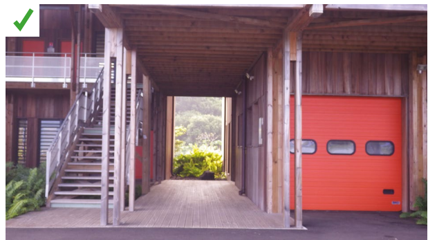
Mise en œuvre de lames en bois dur pour un platelage en zones extérieures exposées. ©AQC
