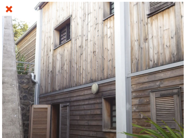
Le grisaillement du bardage est hétérogène sur une même façade. L'ombre portée du mur de soutènement à gauche engendre une moindre exposition aux UV des rayons du soleil et un séchage plus long de la partie basse du bardage. ©AQC
