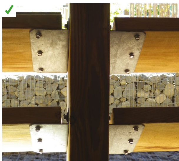
Fixation des lames de brise-soleil au montant en bois par des équerres métalliques assurant la bonne évacuation de l'eau de pluie. ©AQC
