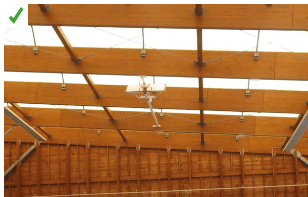
Mise en œuvre d'une ossature en BLC protégée des UV et de la pluie dans un local fortement ventilé naturellement. ©AQC
