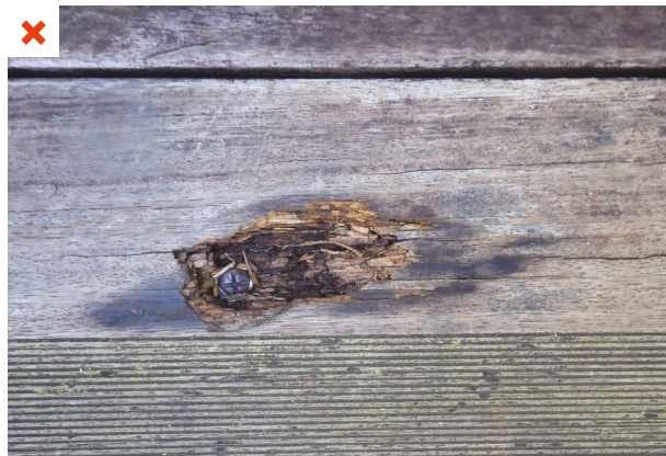
Dégradation ponctuelle d'une planche de platelage à proximité de la vis de fixation trop enfoncée. ©AQC
