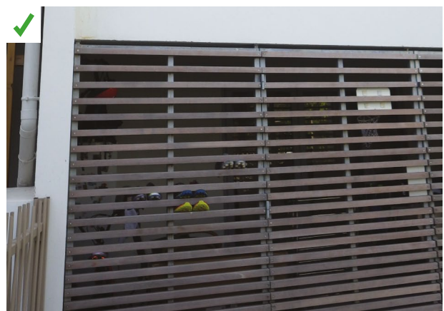
Le choix des lames en bois dense et le dimensionnement des supports de fixation métallique assurent une stabilité de l'ouvrage dans le temps. ©AQC
