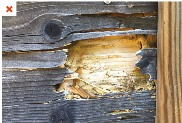
Dégradation du bardage bois fortement exposé à la pluie, par des champignons lignivores. ©AQC
