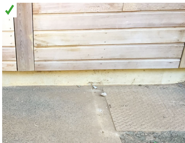
Respect de la distance de 20 cm préconisée par le NF DTU 41.2 P1-1. ©AQC
