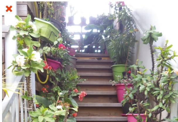
Des plantes d'ornement ont été disposées dans l'escalier en bois. Sans sous-coupe, l'eau d'arrosage humidifie régulièrement les lames en bois et l'humidité stagne sous les pots de fleurs. ©AQC
