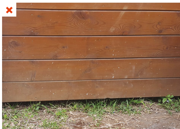
Forte diminution de la garde au sol du bardage bois à la suite de l'ajout de terre végétale par l'entreprise VRD lors des aménagements des jardins. Cela limite la ventilation de la lame d'air à l'arrière du bardage bois et par conséquent la pérennité de l'installation. ©AQC
