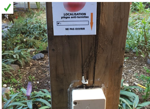
Installation de pièges anti-termites sur une structure à ossature bois. ©AQC
