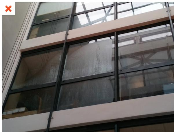
Seules les vitres des bureaux climatisés présentent une condensation sur la partie extérieure du vitrage. Les châssis, plus performants thermiquement que les vitrages, ne sont pas impactés. ©AQC
