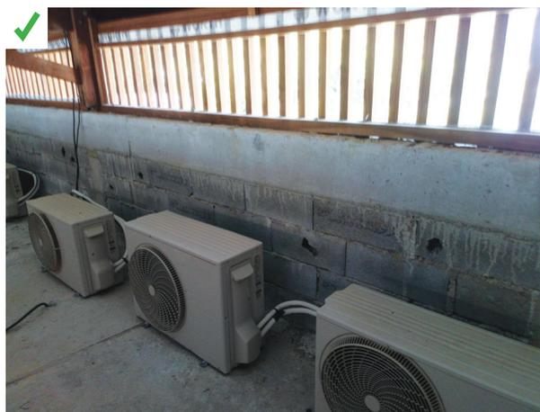
La ventilation des combles accueillant les unités extérieures de la climatisation est assurée par un espace non fermé. ©AQC
