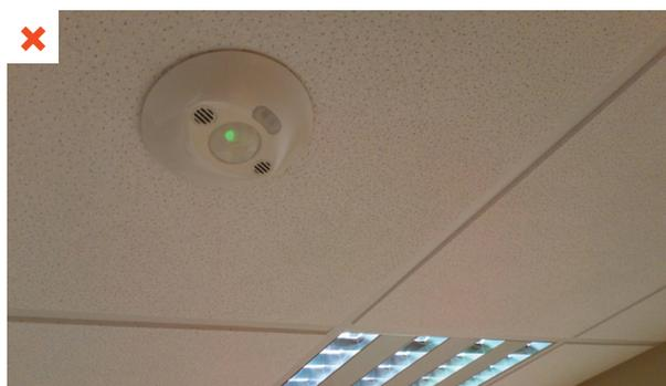
Cellule de détection couplée au déclenchement de l'éclairage artificiel dans un bureau aveugle : l'utilisateur doit agiter les bras pour obtenir un éclairage continu. ©AQC
