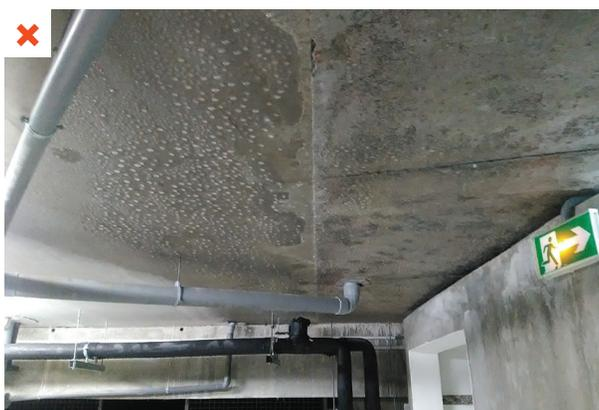
Gouttelettes de condensation en sous face du plancher bas non isolé d'un local climatisé. L'air chaud et humide du sous-sol condense sur la dalle béton plus froide. ©AQC
