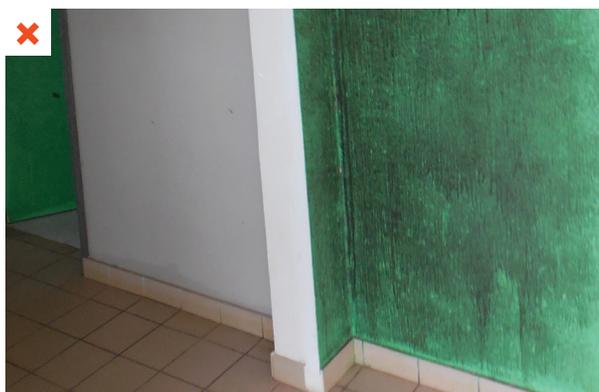
Développement de moisissures sur la partie extérieure d'un mur maçonné non isolé. Ce mur sépare une pièce climatisée d'un espace de circulation non climatisé. ©AQC
