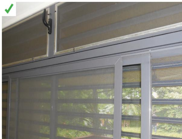
Triple menuiserie permettant une bonne étanchéité à l'air en cas de climatisation, une ouverture facile pour la ventilation naturelle et une protection contre les nuisibles (moustiquaire). ©AQC
