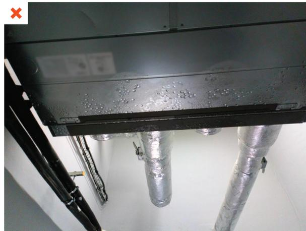
Condensation sur les parois non isolées du caisson de distribution de la CTA. ©AQQC
