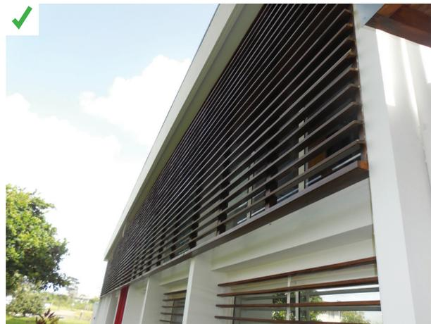
Protection des vitrages et d'une partie des parois opaques verticales par des lames en bois. Le reste des parois verticales sont peintes en blanc pour limiter l'absorption des rayons solaires. ©AQC
