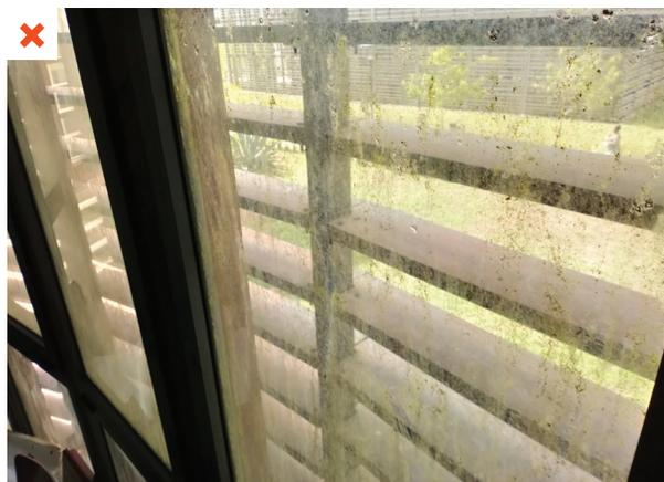
La condensation régulière, sur la partie extérieure des vitrages, est à l'origine de développement de mousses et de moisissures. ©AQC
