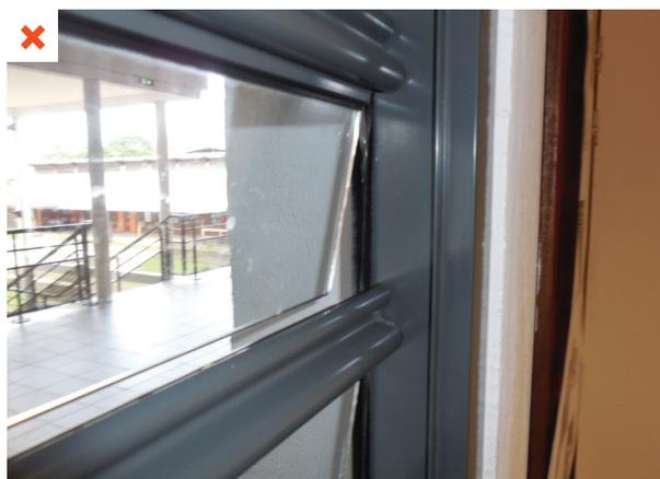
Les joints d'étanchéité à l'air et à l'eau des jalousies sont dégradés prématurément. Les cycles répétés d'ouverture - fermeture pour le passage de la ventilation naturelle à la climatisation en sont à l'origine. ©AQC
