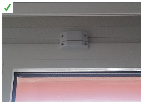
Contact de feuillure installé sur les ouvrants permettant l'arrêt automatique de la climatisation en cas d'ouverture d'une fenêtre. ©AQC
