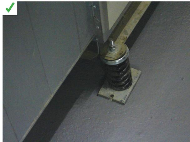
Plots anti-vibratiles permettant de désolidariser l'unité extérieure de la dalle. ©AQC
