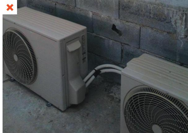
Unités extérieures de climatisation posées à même la dalle haute, sans dispositif antivibratoire, créant de l'inconfort acoustique pour les occupants. ©AQC
