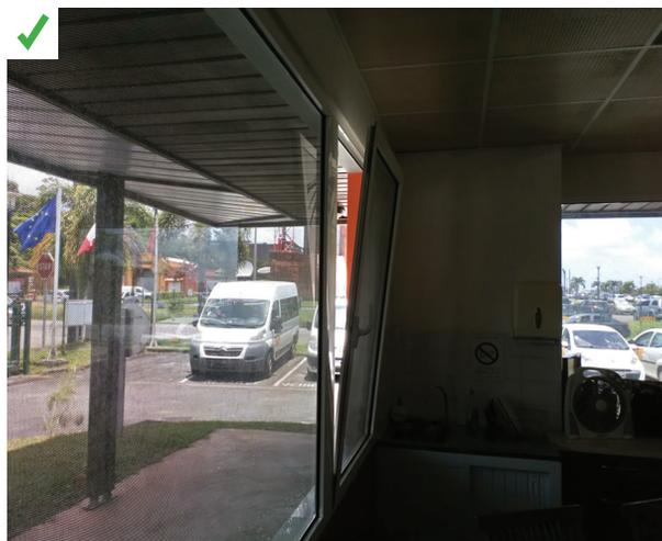
Une fenêtre oscillo-battante a été installée permettant une bonne étanchéité à l'air en position fermée et une utilisation pour la ventilation naturelle. ©AQC
