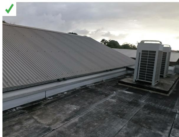
Unités extérieures de climatisation ré-installées à l'extérieur des combles sur silent-blocs et sur une dalle séparée. ©AQC
