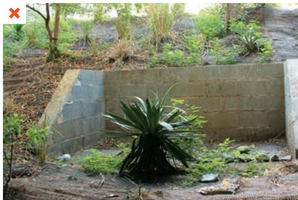
Pente trop élevée entraînant une érosion du terrain faisant obstacle au développement de la végétation en pied de bâtiment. Bâtiment collectif. ©AQC
