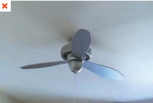
*Le brasseur d'air installé à l'origine est bruyant et donc non utilisé. Par ailleurs, il engendre une vitesse d'air trop faible son diamètre étant insuffisant au regard de la taille de la pièce. Bâtiment collectif. ©AQC*
