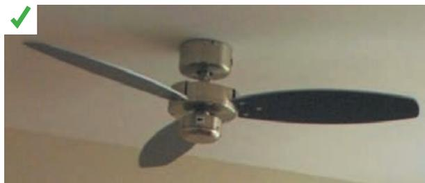
*Dans cette chambre de 12 m², un brasseur d'air de qualité, bien positionné et au diamètre suffisant assure le confort thermique. Bâtiment collectif. ©AQC*
