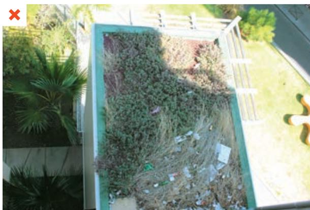
Toiture-terrasse végétalisée inaccessible ne permettant ni l'entretien ni le nettoyage. Bâtiment collectif. ©AQC
