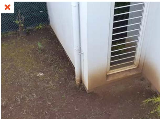
Infiltrations d'eau et de terre à l'intérieur du logement engendrées par les précipitations. Bâtiment collectif. ©AQC
