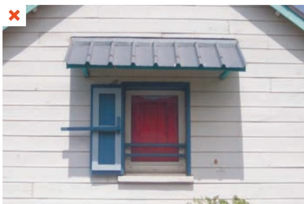
Protection solaire en tôle provoquant une surchauffe locale au niveau de l'ouverture. Maison individuelle. ©AQC
