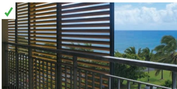
Protection coulissante manipulable selon le souhait de l'occupant permettant la ventilation et la protection contre le vent et le soleil. Façade Est. Bâtiment collectif. ©AQC
