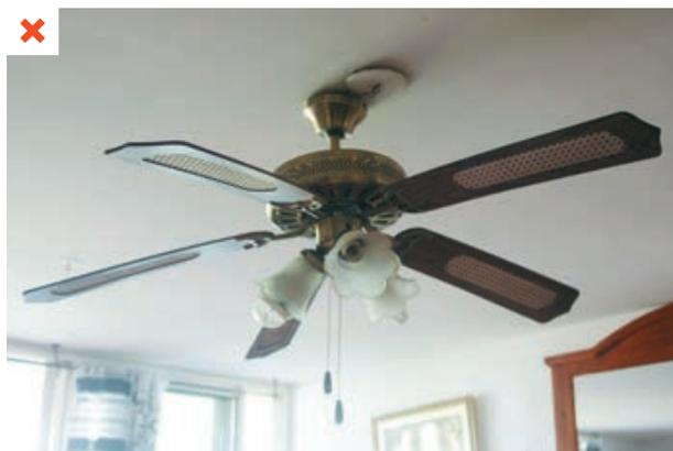
*Le brasseur d'air a été installé dans le séjour par l'occupant. Ses performances ne permettent pas de générer une vitesse d'air satisfaisante. Bâtiment collectif. ©AQC*
