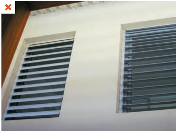
Jalousies non étanches permettant l'infiltration des eaux de pluie. Cette façade non protégée est orientée Nord/Est. Bâtiment collectif. ©AQC
