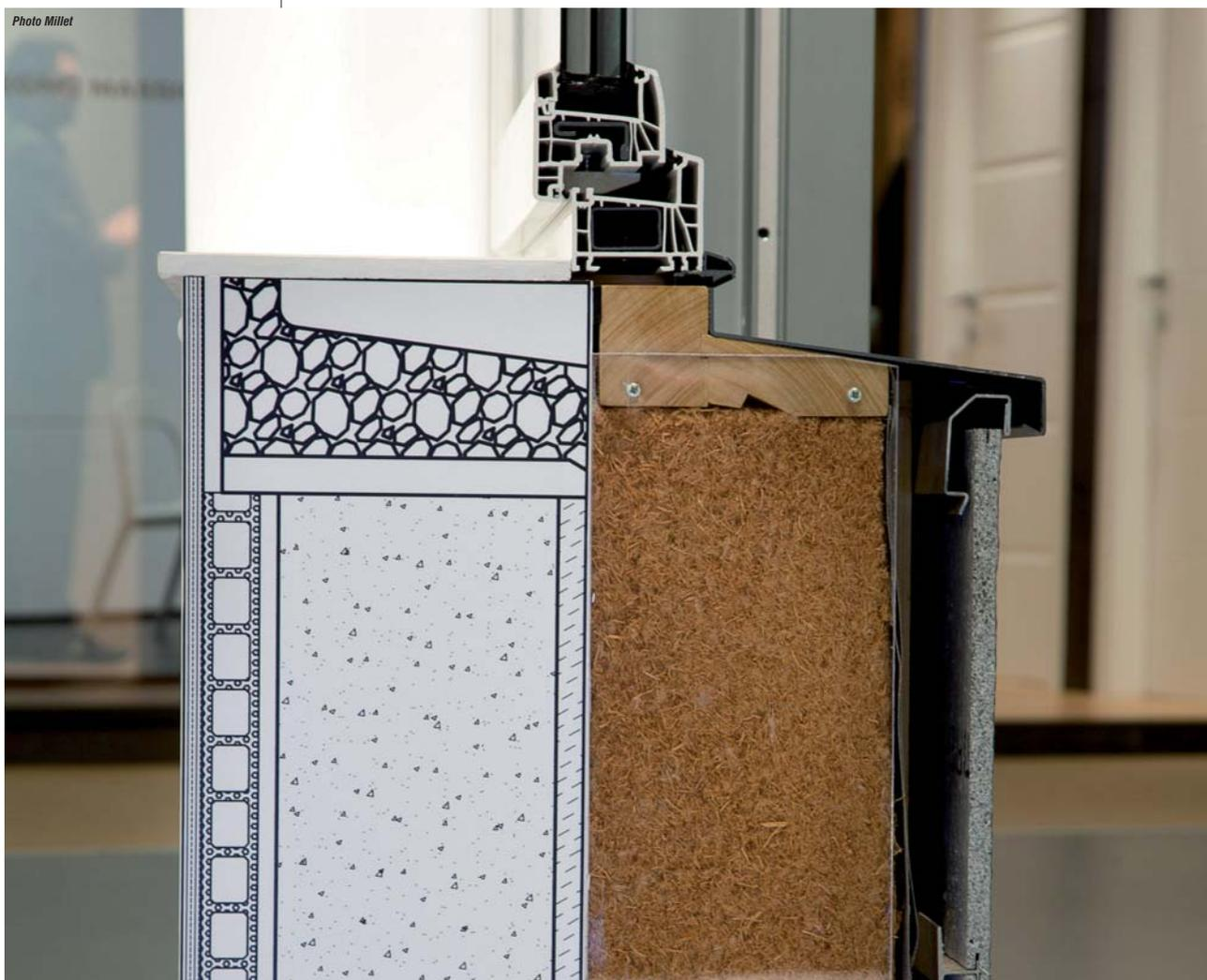
Maquette illustrant la reconstitution complète d'un appui de fenêtre avec pré-cadre bois, dans le contexte d'une rénovation énergétique par l'extérieur avec couche d'isolant épaisse.
