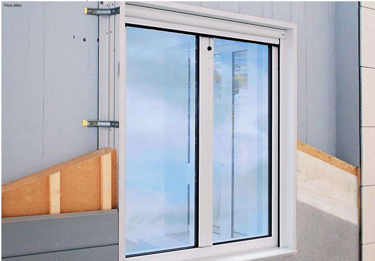
La pose des fenêtres en applique extérieure limite les ponts thermiques au strict minimum.
