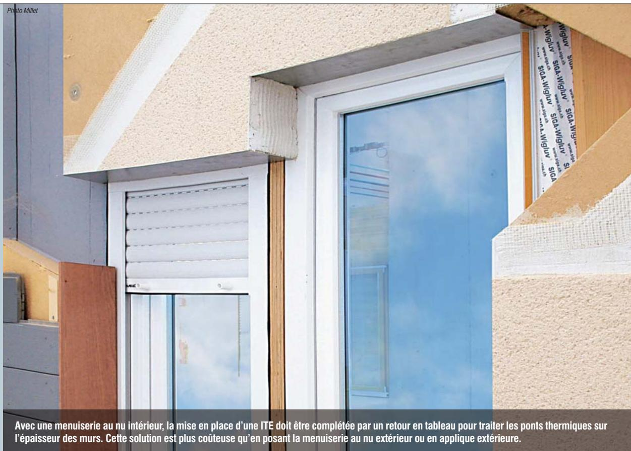
Avec une menuiserie au nu intérieur, la mise en place d'une ITE doit être complétée par un retour en tableau pour traiter les ponts thermiques sur l'épaisseur des murs. Cette solution est plus coûteuse qu'en posant la menuiserie au nu extérieur ou en applique extérieure.
