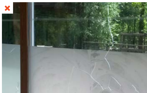
Phénomène de casse thermique avec départ de deux fissures perpendiculaires en partie haute de la baie. La différence d'opacité entre les parties hautes et basses est à l'origine d'un gradient thermique. ©AQC
