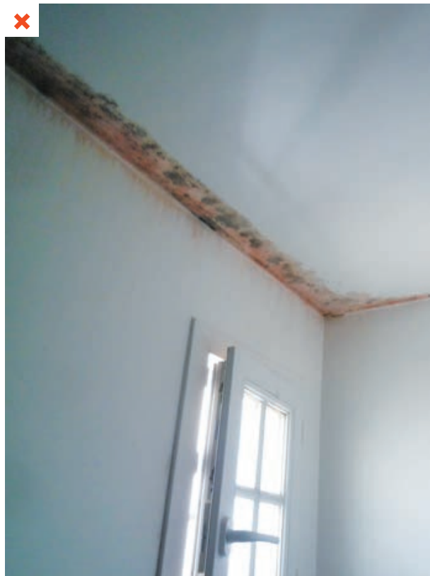
Apparition de phénomènes de condensation importants accompagné du développement de moisissures suite au remplacement des menuiseries anciennes par des menuiseries neuves non munies d'entrées d'air alors que le logement était équipé d'une ventilation simple flux. ©AQC
