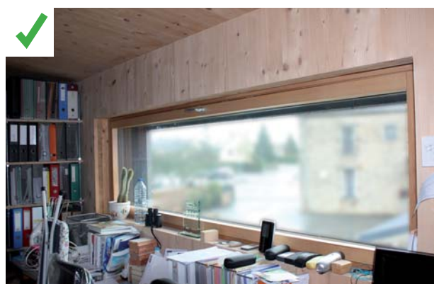
Bandeau horizontal – Triple vitrage – Façade Nord – Projet 2. ©AQC
