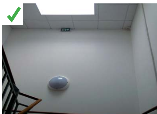
Luminaire éteint situé sous la fenêtre de toit – Gradation – Projet 2. ©AQC
