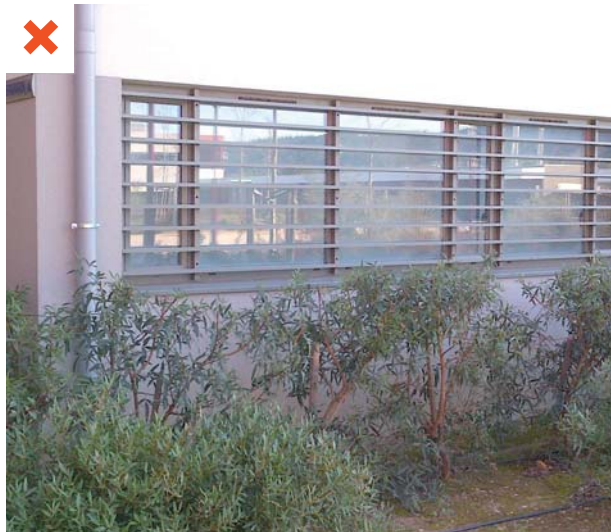
Brises soleil fixes ne permettant pas le nettoyage des vitres. ©AQC
