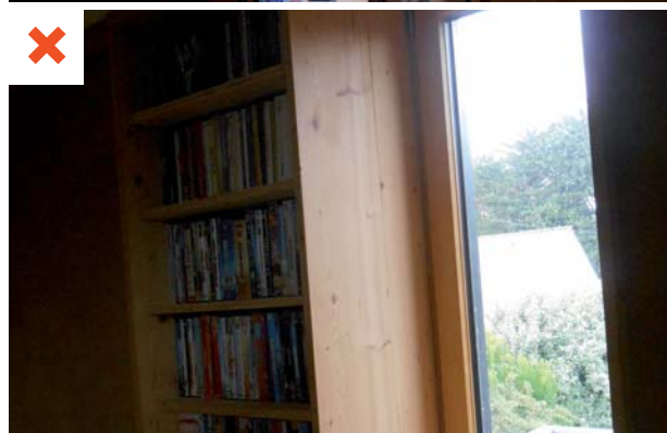
Bandeau vertical et bibliothèque constituant l'ancienne ouverture – Double vitrage – Façade Nord – Projet 1. ©AQC
