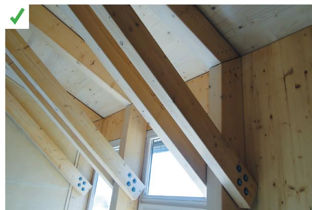
Cette structure poteaux-poutres permet l'installation d'une façade rideau non traversée par des éléments structurels. Cette façade constitue le plan d'étanchéité à l'air dont la continuité est assurée. ©AQC
