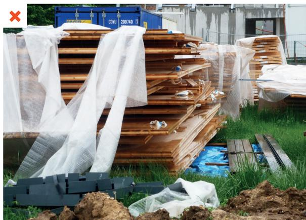
Exemple d'un stockage d'éléments bois mal protégés des intempéries et en contact avec l'humidité du sol. ©AQC
