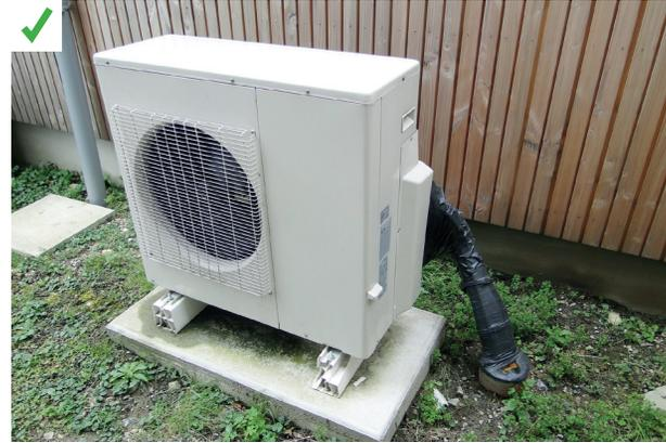
Les réseaux raccordés à cette PAC circulent à travers la dalle afin d'épargner les plans d'étanchéités de l'ossature bois. ©AQC
