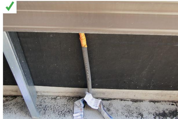
La gaine d'alimentation de l'éclairage extérieur passe ici à travers la dalle béton afin d'éviter les percements des plans d'étanchéités de l'ossature bois. ©AQC
