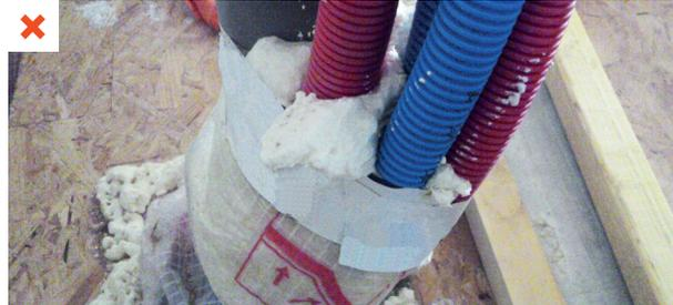
Mauvais traitement de la traversée du plan d'étanchéité à l'air d'un plancher bas. ©AQC
