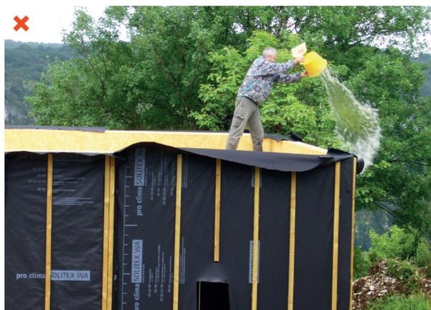
Le bâtiment non protégé (notamment les éléments bois au niveau de la toiture terrasse) est resté longtemps exposé aux intempéries avant d'être mis hors d'eau. ©AQC
