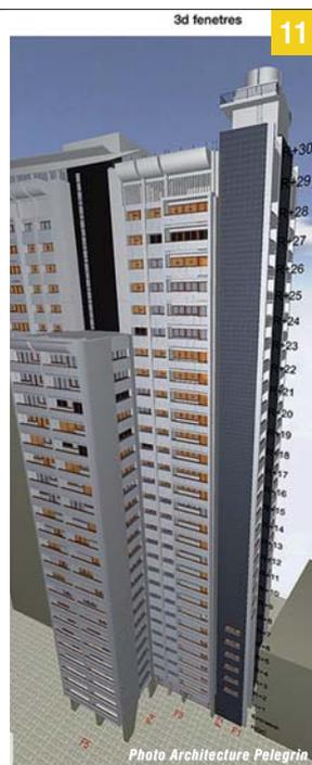
9 La maquette numérique est utilisée par les maîtres d'œuvre et les entreprises pour programmer et suivre le phasage des travaux.
