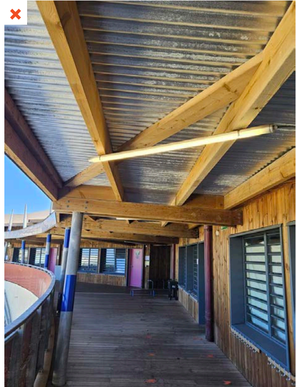
Les éclairages extérieurs sur horloge sont constamment allumés. ©AQC
