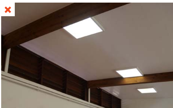
Les dalles lumineuses sont commandées par des détecteurs de présence. L'enseignant n'a pas de contrôle pour allumer ou éteindre en fonction des activités (temps calme, vidéo projection, etc.). ©AQC
