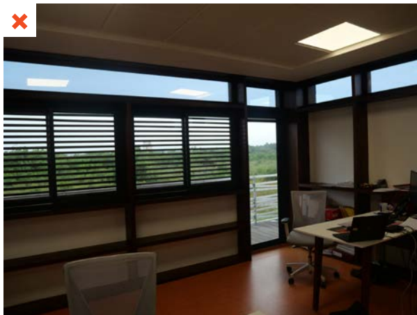
Le poste de travail fixe ne permet pas d'éviter l'éblouissement et les reflets provenant de la porte-fenêtre orientée à l'ouest. ©AQC
