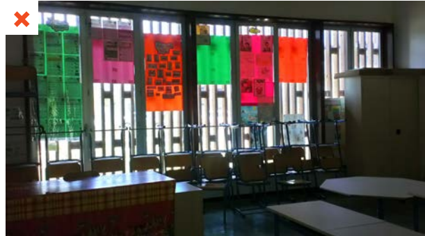
Les protections solaires verticales sont inefficaces en façade est et ouest. Les utilisateurs ont occulté les fenêtres exposées à l'ensoleillement direct. ©AQQC
