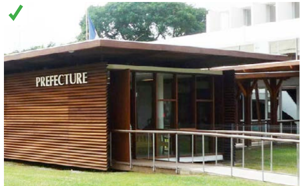
Les fenêtres sont implantées sur les façades nord et sud. Les jalousies en bois fixes sont implantées sur les façades est et ouest pour favoriser la ventilation naturelle. ©AQQC
