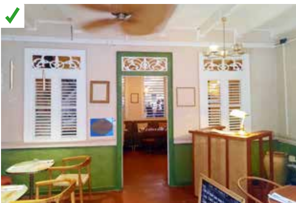
Dans les maisons traditionnelles créoles, si les pièces sont délimitées par des étraves et des menuiseries, des impostes et des jalousies favorisent la ventilation traversante. ©AQC
