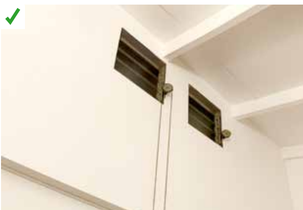
L'ajout d'impostes permet, a minima, de retrouver une circulation de l'air, ce qui diminue l'usage de la climatisation. Le dimensionnement de ces impostes semble cependant insuffisant pour une ventilation naturelle efficace. ©AQC
