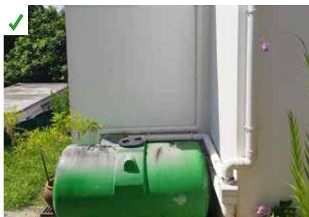
Un réservoir en polyéthylène permet ici une récupération et un stockage de l'eau de pluie dans de bonnes conditions. ©AQC
