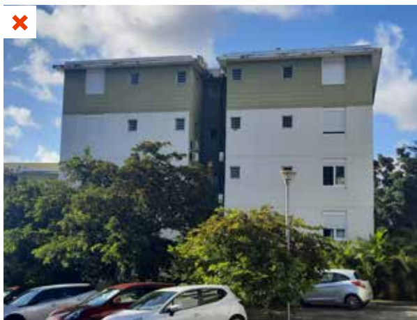
Les UE de climatisation sont regroupées au même endroit et à proximité d'ouvertures utilisées pour la ventilation naturelle. Un îlot de chaleur est créé et l'air chaud entre dans le bâtiment.
