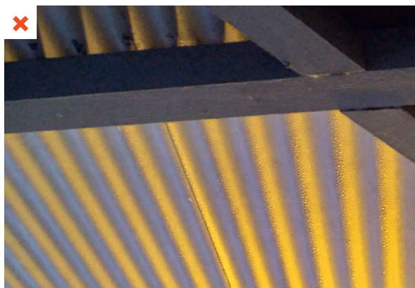
Des gouttes d'eau de condensation se forment en sous-face de la tôle. ©AQC
