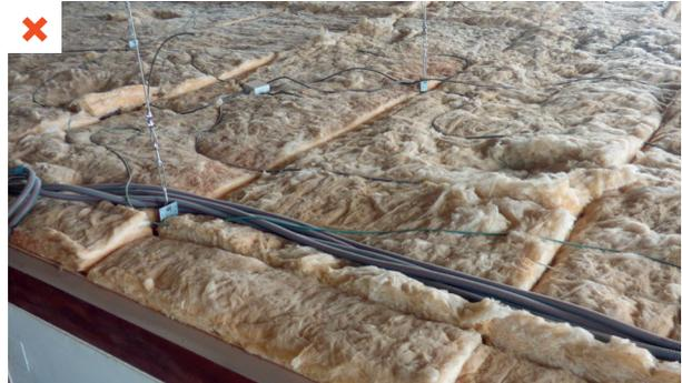
L'isolant en laine minérale, posé sur le faux plafond d'une pièce climatisée, est muni d'un kraft. Ce dernier est positionné côté froid, ce qui peut faire barrière à la migration de la vapeur d'eau et provoquer de la condensation dans l'isolant. ©AQC
