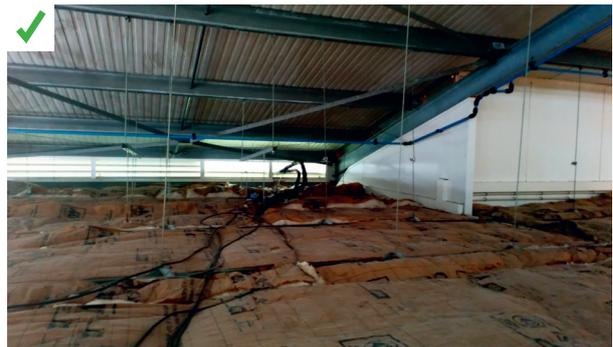
L'isolant mis en œuvre sur le plafond d'un espace climatisé est muni de kraft jouant le rôle de frein vapeur. Ce dernier a été positionné côté chaud. De plus, la sous-toiture est ventilée grâce à des entrées d'air bien dimensionnées. ©AQC
