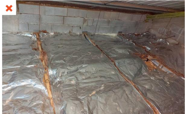
L'isolation du plancher des combles perdus au-dessus d'une pièce climatisée est assurée par des rouleaux de laine minérale comportant un pare-vapeur intégré. Ce dernier est bien positionné du côté chaud et humide, mais n'est pas continu. En effet, les lés ne sont raccordés ni entre eux ni à la maçonnerie périphérique. ©AQC
