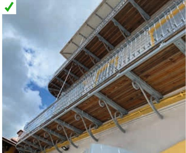
Maintien des garde-corps et des consoles d'origine faisant office de protections solaires, lors d'un projet de réhabilitation. ©AQC
