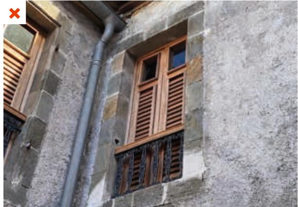
Le garde-corps, nouvellement installé, ne respecte pas les dimensions d'origine. Par ailleurs, le dimensionnement ne répond pas aux normes en vigueur en matière de sécurité (MHI). ©AQC
