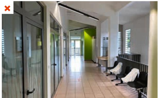
Cloisonnement d'un espace entraînant une impossibilité d'avoir recours à la ventilation naturelle et créant une surchauffe dans l'espace d'accueil et donc entraînant le recours à la climatisation dans les bureaux créés. ©AQC
