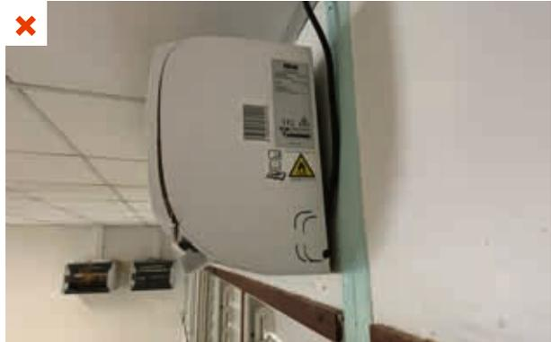
La climatisation, installée sans remplacement de la menuiserie, est inadaptée à ce type d'usage (nécessité de menuiseries avec des joints d'étanchéité pour les pièces climatisées). ©AQC
