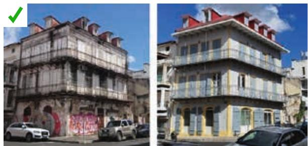
Rénovation d'une maison bourgeoise en centre ancien. Reconstruction à l'identique en ajoutant une couverture sur le balcon en R+2 avec l'accord préalable de l'Architecte des Bâtiments de France (ABF). ©AQC
