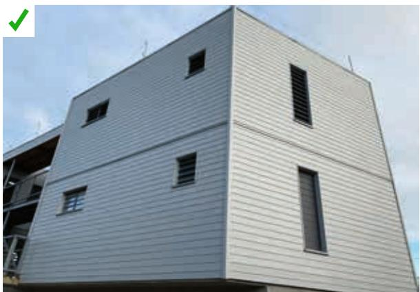
Rez-de-chaussée en béton associé à deux niveaux supérieurs d'habitation avec couverture intégralement construits en ossature bois et bardage bois. Ce dispositif respecte les normes parasismiques et paracycloniques en vigueur. ©AQQC
