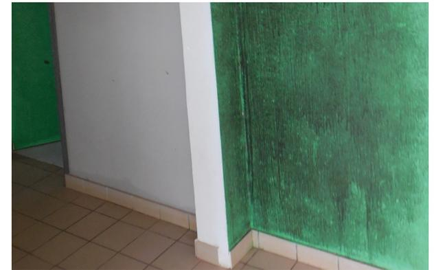
*Développement de moisissures sur la partie extérieure d'un mur maçonné non isolé. Ce mur sépare une pièce climatisée d'un espace de circulation non climatisé. ©AQC*
