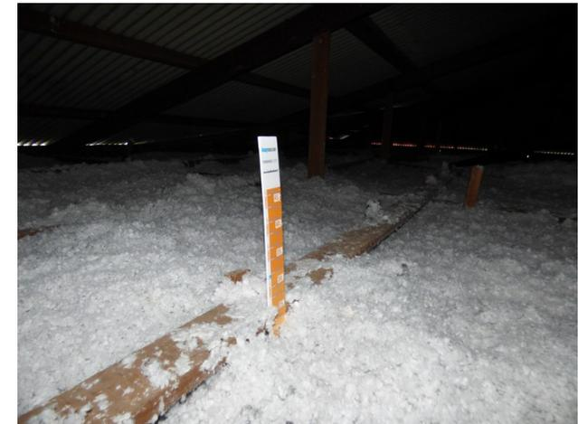
*La régularité d'épaisseur de l'isolant soufflé en vrac est contrôlée à l'aide de réglettes graduées. ©AQC*
