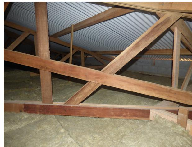
*La couche d'isolant recouvre les éléments de la structure porteuse du plafond, ce qui limite ainsi les ponts thermiques. ©AQC*
