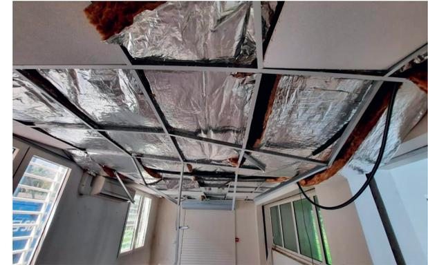
*Effondrement du plafond suspendu après isolation. Sa structure métallique (primaire et/ou secondaire) sous-dimensionnée n'a pas supporté le poids de l'isolation rapportée. ©AQC*
