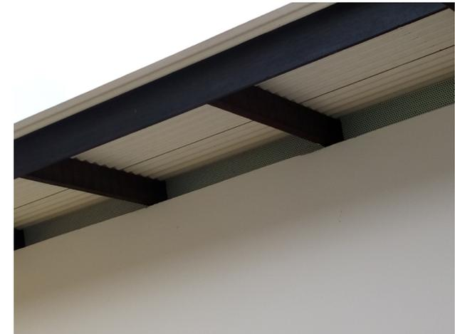
© AQC : Mise en place de grilles antinuissibles
