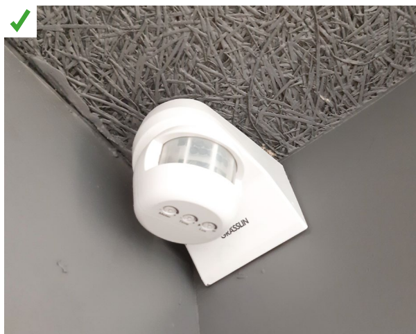
Le réglage de la luminosité, de la temporisation de l'éclairage et de la sensibilité/portée est possible grâce aux trois potentiomètres. ©AQC
