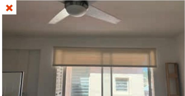
Le store de protection solaire est positionné à l'intérieur. D'une part, il ne limite pas suffisamment l'entrée des calories derrière le vitrage et, d'autre part, il restreint le flux d'air entrant lorsque les fenêtres sont ouvertes. ©AQC
