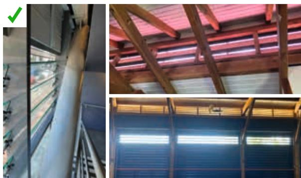
La mise en œuvre de ventelles fixes (photo de gauche en hauteur et en retrait de façade) ou réglables (ventelles réglables sur toiture) facilite le renouvellement d'air continu de l'espace. Ces installations doivent être protégées des intempéries et sécurisées afin de pouvoir rester ouvertes même en cas d'absence.
