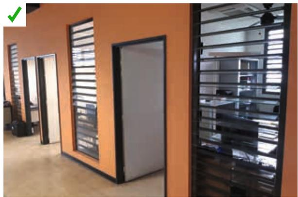
✓ Bâtiment de bureaux en ventilation naturelle. Mise en œuvre de jalousies sur les cloisons intérieures opposées aux ouvertures extérieures. La circulation d'air est traversante d'une façade à l'autre du bâtiment sans interruption par les cloisons intérieures. ©AQC
