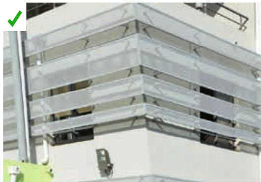
Protections solaires réalisées par le biais d'un bardage métallique ou de volets à projection ajourés (laissant passer l'air) en extérieur. ©AQC
