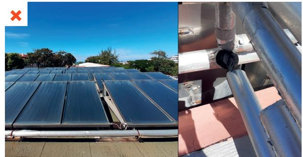
Surface utile de capteurs trop importante pour une cuisine satellite : une cuisine satellite nécessite un besoin en ECS nettement plus faible qu'une cuisine centrale. Après plusieurs années de fonctionnement, une partie des champs a été déconnectée du réseau (illustration de droite). ©AQC
