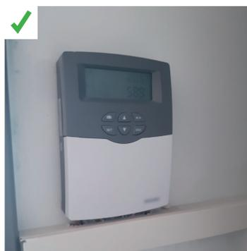
Exemple d'une interface de régulation simple avec des fonctions de base pour un usage par l'utilisateur final non expert. ©AQC
