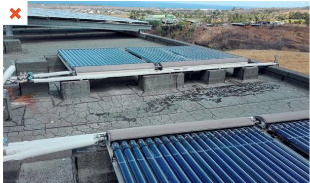
Installation solaire commune à deux espaces distincts. Les linéaires de distribution entre les nappes de capteurs et le stockage sont importants. ©AQC
