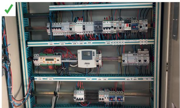
Exemple d'une régulation relativement complexe avec ajout d'une interface permettant une régulation plus simple, notamment pour les opérations de maintenance et de pilotage par l'utilisateur. ©AQC
