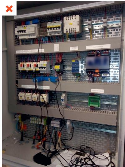
Absence d'interface pour cette régulation complexe. Les entreprises de maintenance et les usagers/exploitants ne peuvent pas suivre, contrôler et optimiser l'installation. ©AQC
