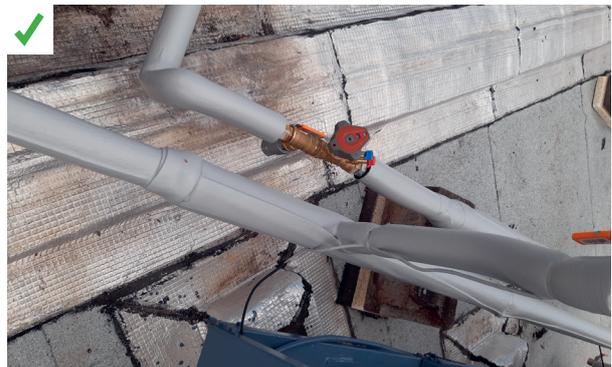
Une vanne d'équilibrage est installée sur chaque nappe de capteurs, ce qui permet un réglage optimal du réseau. Une coque isolante devrait être présente sur l'organe d'équilibrage. ©AQC
