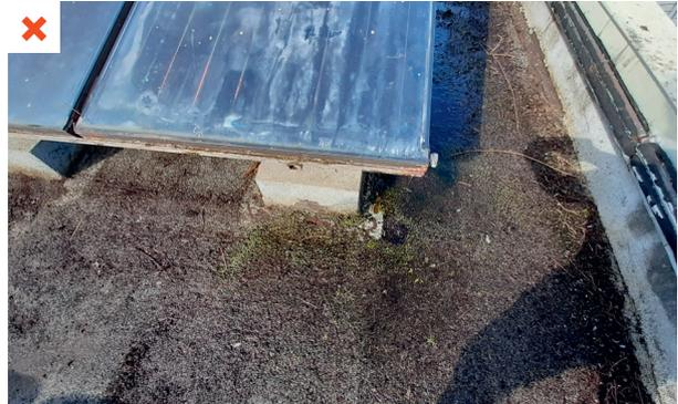
Dégâts dus à une surchauffe des capteurs. ©AQC
