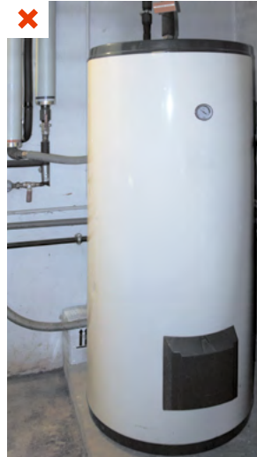
Ballon ECS en chaufferie relié à un long bouclage de distribution imposant le maintien en chauffe des chaudières (2 x 600 kW). ©AQC
