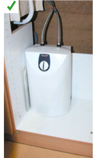
Ballon sous lavabo dans un cabinet de médecin. ©AQC
