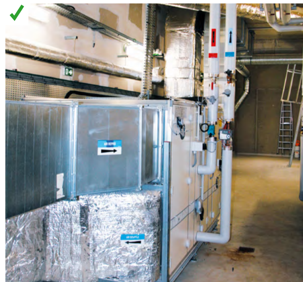
Régulation terminale par vannes deux voies associées à une pompe à débit variable permettant de réduire le débit dans la CTA. Ceci permet également de diminuer la consommation électrique des auxiliaires qui sont moins sollicités. ©AQC
