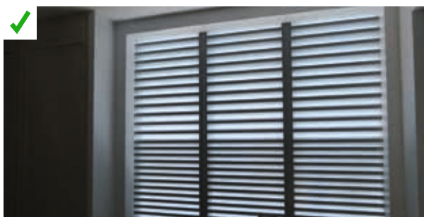
Ventelles fixes (type lame Z) dont l'espacement permet de garantir le respect des normes incendie. L'écart dégressif vers le bas contribue à la protection contre les intempéries. ©ANCO
