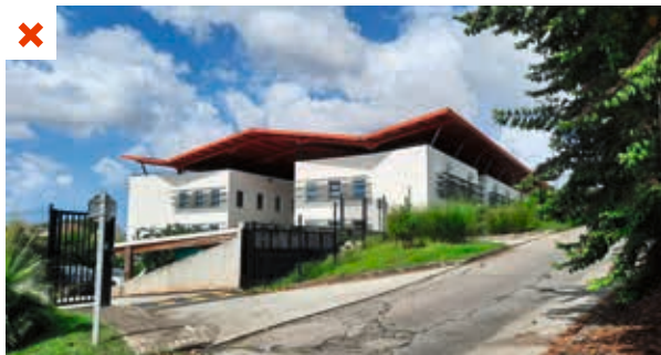
Le positionnement de cet ouvrage a été pensé pour limiter les opérations de terrassement et avoir le moins d'impacts visuels possible. La localisation de l'ouvrage sur la parcelle, dans la pente et sous le vent, réduit le potentiel de ventilation naturelle au sein de l'ouvrage.
