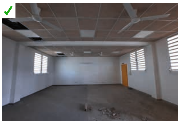
Dans cette salle de classe, les ouvertures ont été positionnées sur les deux façades ce qui assure une ventilation traversante à l'échelle de la pièce. ©AQC
