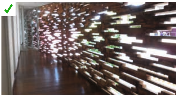
Réalisation d'un mur en moucharabieh permettant la ventilation de cette circulation et l'évacuation des fumées. ©AQC
