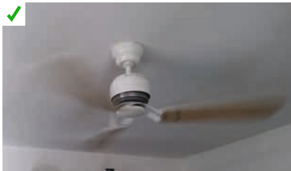
Fonctionnement constant des brasseurs d'air dans une partie des espaces du bâtiment pour pallier les défauts de ventilation naturelle. ©AQC
