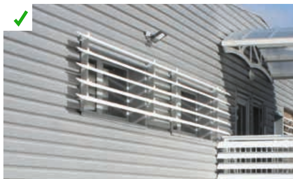
Les vitrages sont protégés efficacement sur la façade Ouest grâce à un brise-soleil convenablement dimensionné. L'accès à la lumière naturelle est conservé. ©AQC
