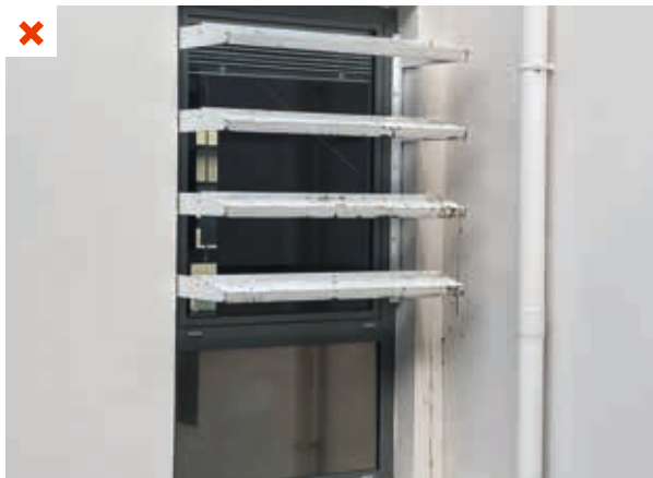
Les protections solaires sont directement fixées sur le cadre de la menuiserie et risquent de s'arracher en cas de vents forts.
