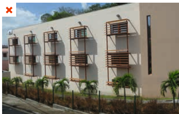
Malgré un dimensionnement, un espacement et une inclinaison corrects, ces brise-soleil ne protègent pas les baies, car ils sont trop éloignés de la façade. Par ailleurs, l'ombre portée indique un soleil proche du zénith. Une casquette aurait donc pu suffire à protéger efficacement ces ouvertures. ©AQC
