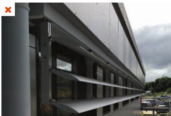
Les brise-soleil sont fixés uniquement en console alors qu'ils courent tout le long de la façade. L'absence de fixations en partie basse et la longueur des lames peuvent amener l'ensemble à plier et à céder en cas de vents importants.
