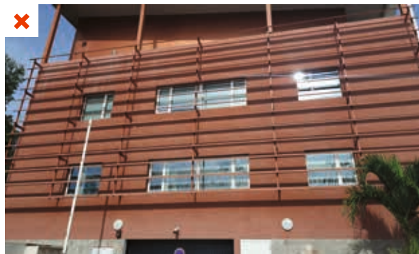
Des brise-soleil parcourent les étages de cette façade ouest. Néanmoins, l'écartement trop important des lames et leur inclinaison rendent le dispositif peu efficace. ©AQC
