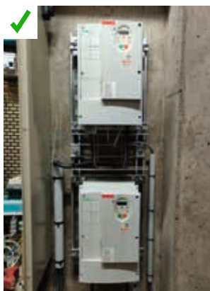
Pompe à débit fixe équipée d'un variateur de fréquence. ©AQC
