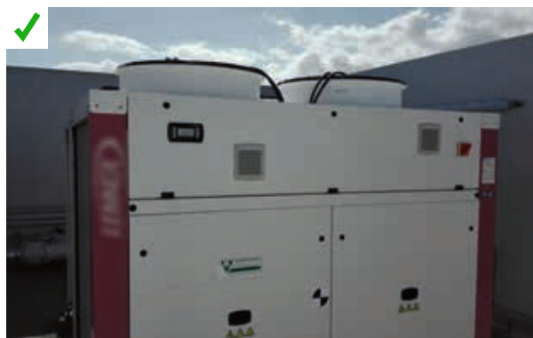
Un enclos maçonné autour du groupe froid a été prévu en conception. Il assure une protection du groupe froid à l'air salin direct. ©AQQC
