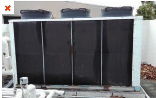
L'air salin entraîne rapidement de la corrosion. Les supports et pièces métalliques comme les boulons et autres fixations ainsi que les échangeurs sont impactés. ©AQQC
