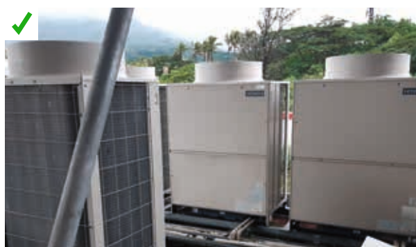
Modularité de la production de froid : plutôt que d'avoir un seul groupe pour l'ensemble du bâtiment, chaque étage est alimenté par une production distincte. ©AQC
