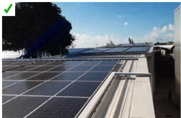
Installation PV approvisionnant le groupe froid qui alimente lui-même le stockage latent via un automate de gestion. ©AQC
