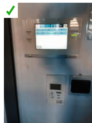
Mise en œuvre d'une télécommande centrale sur un DRV dans le bureau du responsable afin de gérer les horaires, l'extinction et les températures de consigne par salle. ©AQC
