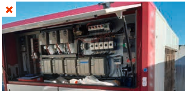
Groupe froid surdimensionné par rapport aux besoins réels en raison de l'absence de STD fine et sans prise en compte du foisonnement. ©AQC
