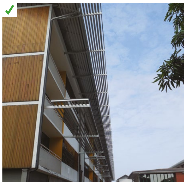
Travail sur la protection solaire d'un bâtiment rénové : pose de couverture avec débords importants, de brise-soleil horizontaux et verticaux à 2 niveaux, de bardage sur le pignon. ©AQC
