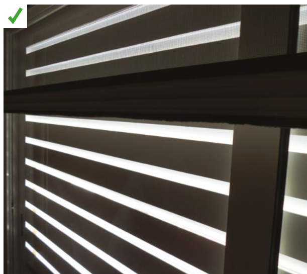
Triple menuiserie : volet, moustiquaire et fenêtre coulissants permettant le choix entre la ventilation naturelle ou la climatisation sans déperditions énergétiques. ©AQC
