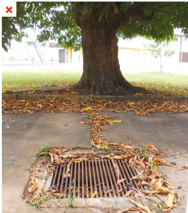
Manguier à proximité du réseau d'évacuation des eaux pluviales. ©AQC
