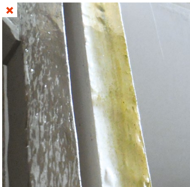
Absence de protection d'une façade exposée à la pluie provoquant la dégradation accélérée des matériaux de structure. ©AQC
