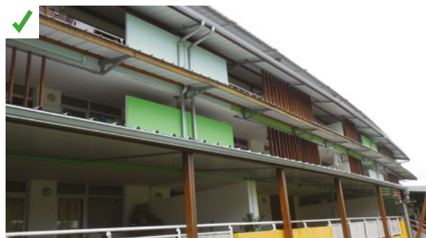
Pose d'auvents limitant l'impact solaire sur les éléments du bâti. ©AQC
