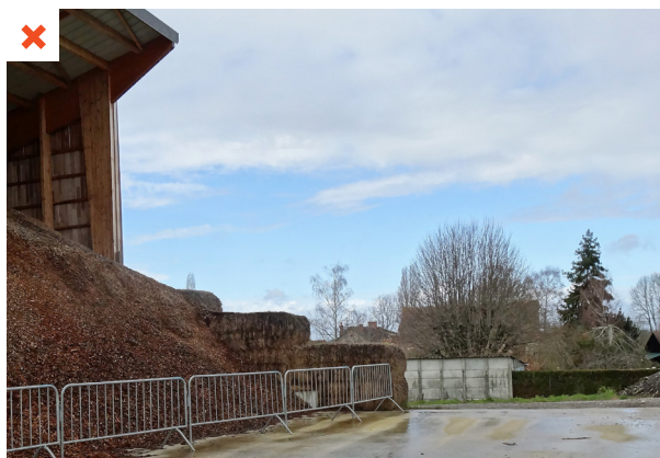
Une partie du stockage du combustible se trouve à l'air libre, en dehors de l'aire protégée des intempéries.
