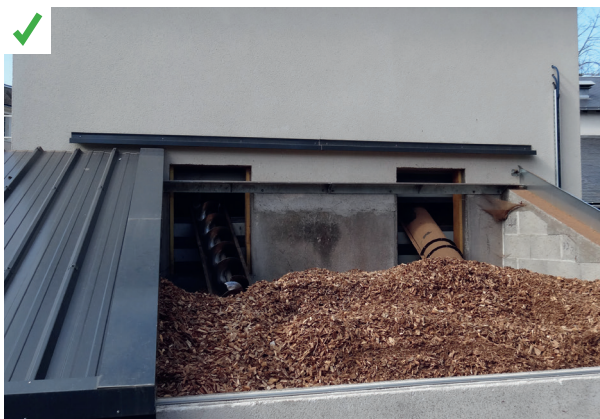
Système de convoyage direct avec deux vis sans fin fonctionnant en parallèle depuis la trémie vers le silo. ©AQC
