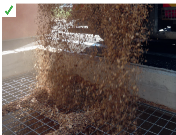
La présence d'une grille sur le silo de dépotage facilite le contrôle visuel et permet de retenir les plus grosses pierres. ©AQC
