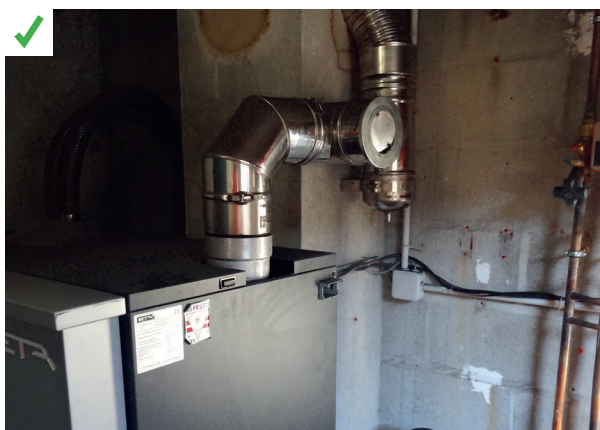
L'installation d'un modérateur de tirage permet de contrôler l'excès ou l'insuffisance de tirage. Le clapet, motorisé ou mécanique, s'ouvre plus ou moins en fonction de la valeur de la dépression dans le conduit. ©AQC
