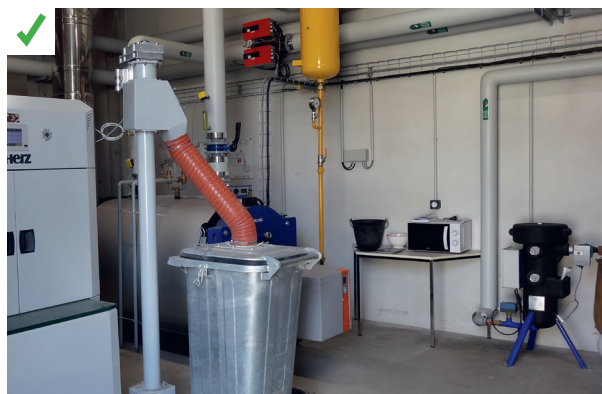
Installation d'un poste de contrôle d'humidité des plaquettes dans le local chaufferie composé d'un micro-onde et d'une balance type pèse-lettre.
