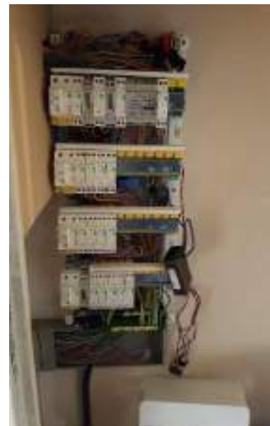
Figure 174 ci-contre : Illustration de la pose de pinces ampèremétriques dans le tableau électrique d'une maison.
