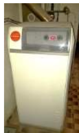
Figure 145 : photo des chaudières gaz conservées et présentant de faibles rendements. Celle de gauche est de 1998, l'année des deux autres n'est pas connue.
