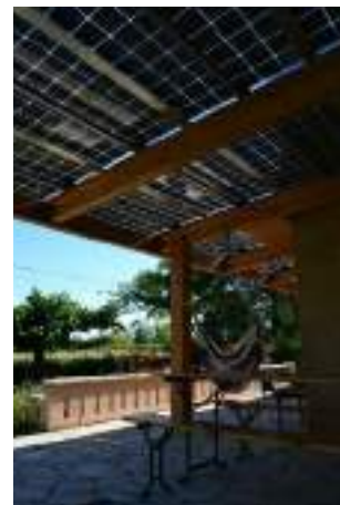
Installation photovoltaïque semi-transparente sur pergola bois
