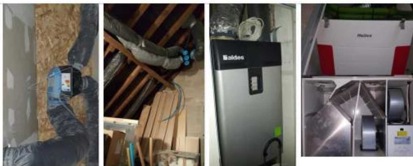
Figure 101 : Illustration de caissons d'extraction simple flux (gauche) et de centrales double flux (droite)
