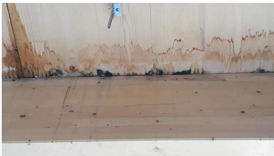
Figure 5 – Exemple de bleuissement à la jonction plancher CLT/Poutre suite à une humidité excessive en phase chantier
