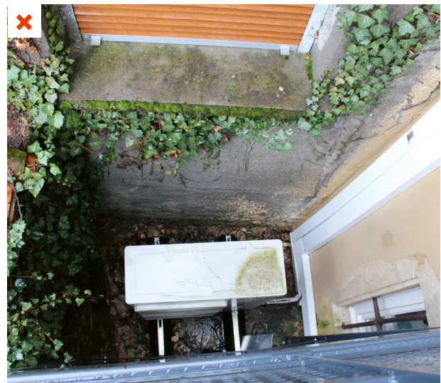
L'unité extérieure de la PAC est située dans une cour intérieure à l'aplomb de la fenêtre ce qui entraîne des nuisances sonores pour les occupants. ©AQC
