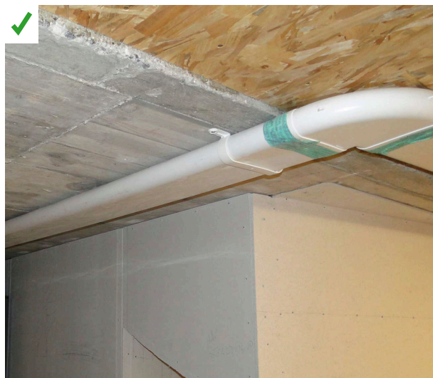
La mise en place de gaines oblongues permet de pallier le manque de hauteur disponible. ©AQC
