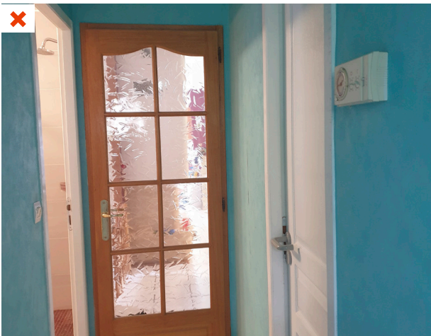
Le thermostat de l'installation de chauffage par radiateurs est face à la salle de bains. Il est perturbé par l'apport de chaleur du sèche-serviette électrique. ©AQC
