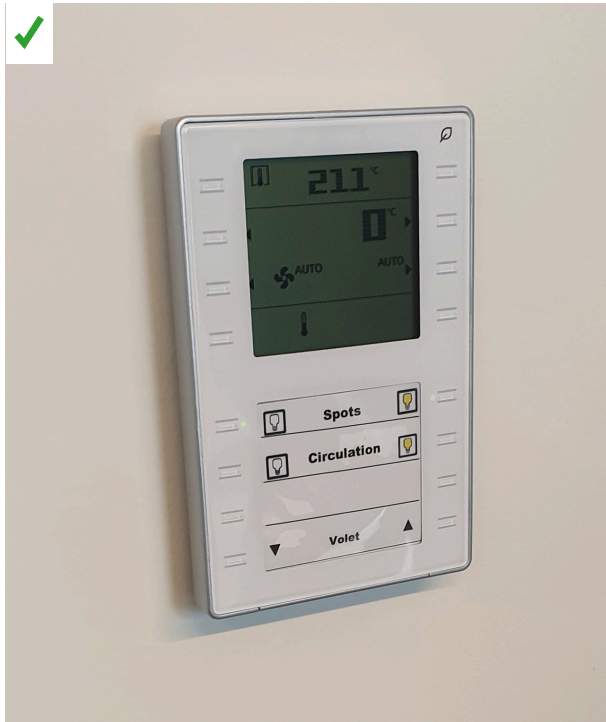
Simplicité de gestion du chauffage, de la climatisation, des volets roulants et de l'éclairage depuis le même module. ©AQC
