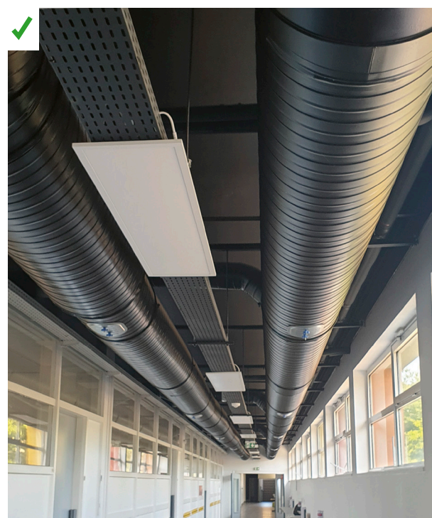
Dans cet établissement scolaire, les gaines de ventilation ont été laissées apparentes pour faciliter leur intégration. ©AQC
