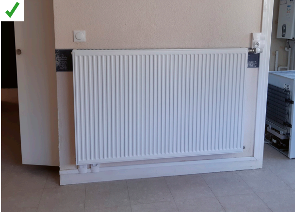
Les radiateurs existants ont tous été remplacés dans cette nouvelle installation en basse température. La surface d'échange importante offre un bon niveau de confort aux occupants. ©AQC
