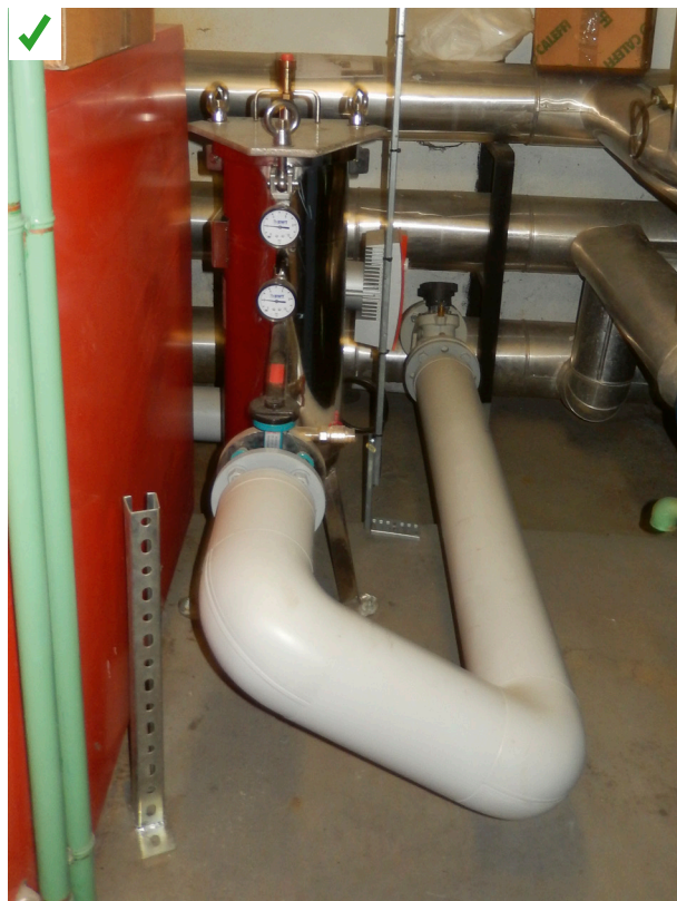
Un filtre magnétique à boue permet de limiter les risques d'embouage du réseau. ©AQC
