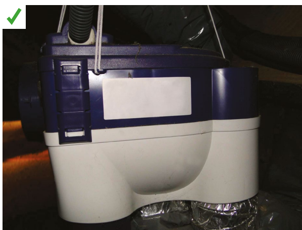
Le caisson d'extraction est désolidarisé du bâti puisqu'il est suspendu à la charpente. ©AQC
