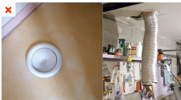
Dans cette pièce, un ancien conduit d'air est toujours présent et entraîne une entrée d'air parasite provenant du garage situé en sous-sol. En plus d'altérer le bon fonctionnement du balayage, de l'air pollué peut entrer dans la pièce. ©AQC
