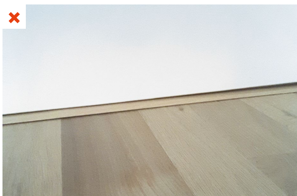
La sur-élévation du niveau du sol fini suite à la pose du parquet et de la barre de seuil entraîne la disparition du passage de transit initialement présent. ©AQC
