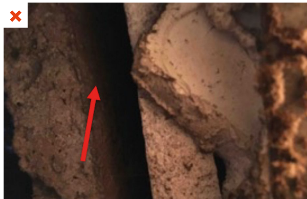
L'espace entre la paroi support de la bouche d'extraction et le conduit vertical de type Shunt ne permet pas d'assurer une continuité de l'étanchéité à l'air du réseau. @Air efficience
