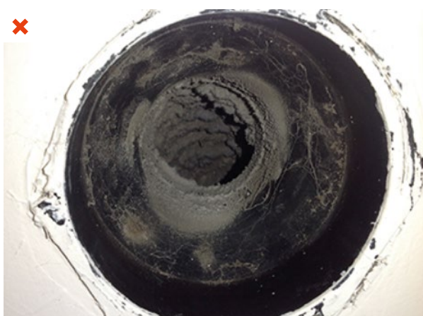
Le conduit flexible d'extraction d'air est fortement encrassé. Le nettoyage du réseau est difficilement envisageable sans dégrader la gaine. ©AQC
