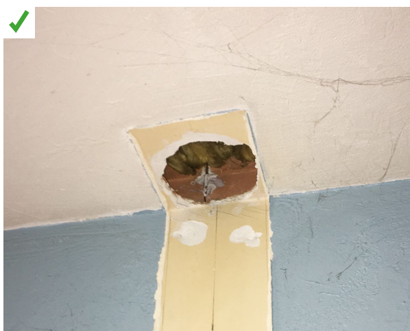
Le passage d'une ancienne gaine de ventilation a été identifié, isolé et va être rendu étanche à l'air. ©AQC
