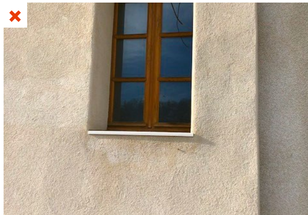
L'isolation par l'extérieur de cette maison s'arrête au niveau du mur mitoyen séparant les deux propriétés. Aucun retour d'isolant par l'ITI n'a été prévu sur ce mur. ©AQC
