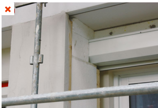
Pont thermique sur toute la longueur du coffre de volet roulant et maintenance impossible sans démontage localisé de l'ITE en appui du coffre. ©AQC
