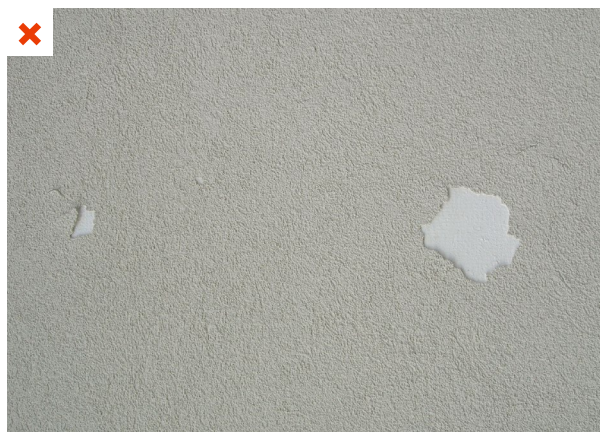
L'enduit du mur support de l'ITE se décolle. La préparation du mur par piquage n'est pas prévue.
