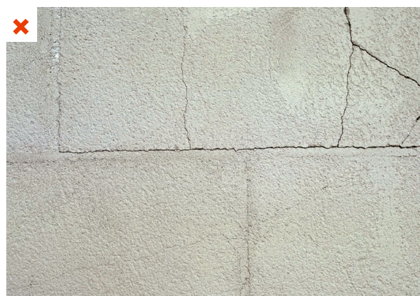
Le support de l'ITE présente des lézardes traversantes. La tenue mécanique de l'isolant par chevilles ne peut être assurée.
