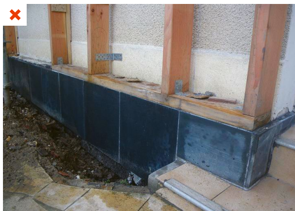
Le soubassement a été isolé avec des panneaux de liège et recouvert d'un parement de protection. Les marches en béton n'ayant pas été désolidarisées, elles créent un pont thermique.
