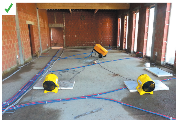
Exemple de dispositif d'assèchement de chantier. ©aerostar
