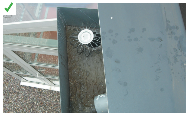
Nettoyage régulier des boîtes à eaux. ©AQC-2016
