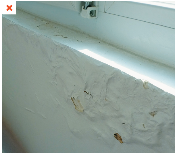
Dégradation des parements du fait de percements de châssis de fenêtres non rebouchés. ©AQC-2016
