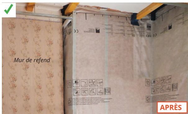
Isolation continue grâce à la coupure du mur de refend (positionné à gauche de la photo). ©AQC-2016
