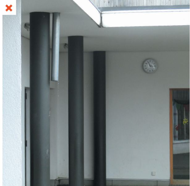
Descente d'eaux pluviales sans évacuation. ©AQC-2016
