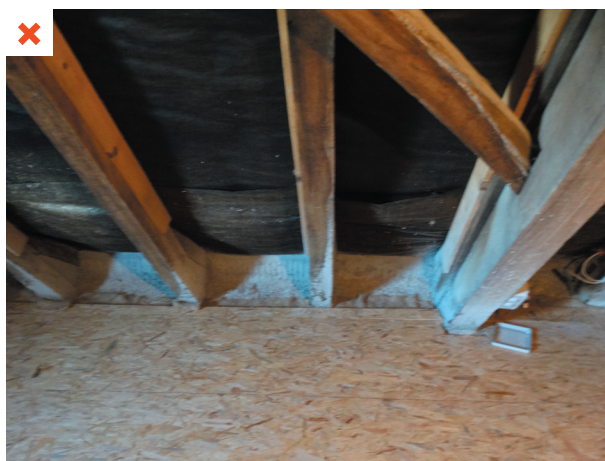
Platelage en OSB d'un plancher haut, situé du côté extérieur de l'isolation, et jointoyé. ©AQC-2016
