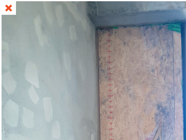
Mise en œuvre d'un OSB qui a moisie durant son stockage, du fait de son exposition à la pluie. ©AQC-2016
