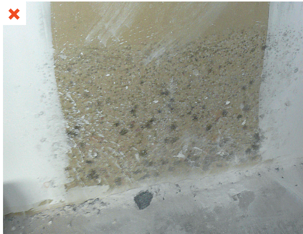
Apparition de moisissures en pied de mur, du fait d'une humidité trop importante au cours du chantier. ©AQC-2016
