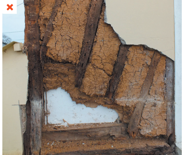
Pan de bois dégradé : le polystyrène côté intérieur a bloqué le séchage du mur vers l'intérieur. ©CoDEM
