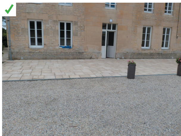
Terrasse équipée d'un caniveau, avec une pente éloignant l'eau du bâtiment. ©AQC-2016
