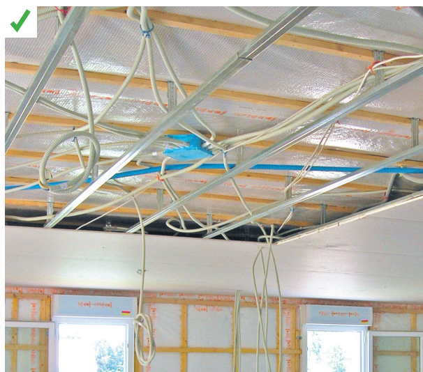
Étanchéité à l'air parfaitement réalisée, présence d'un véritable vide technique, tous les réseaux circulent à l'intérieur du volume étanche à l'air. ©AQC-2016
