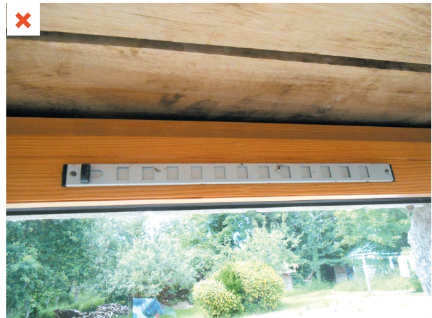
L'absence, la fermeture ou le mauvais dimensionnement des bouches d'entrée d'air frais peut-être responsable de l'accumulation de radon. ©AQC
