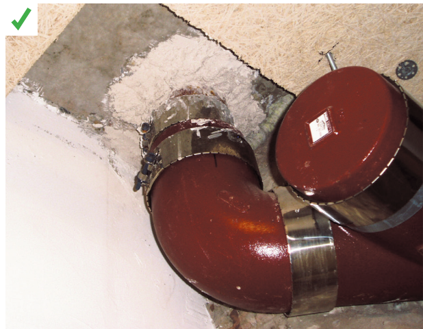
Les défauts d'étanchéité liés au passage des réseaux dans la dalle ont été obturés. © AQC
