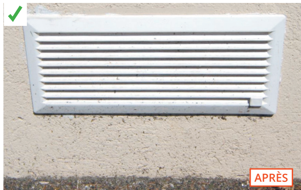
Agrandissement des ouvertures d'un vide sanitaire © AQC
