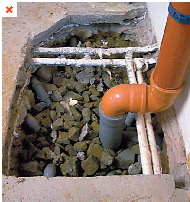
Le passage de la conduite à travers la dalle à l'intérieur du bâtiment n'est pas étanche. ©OFSP
