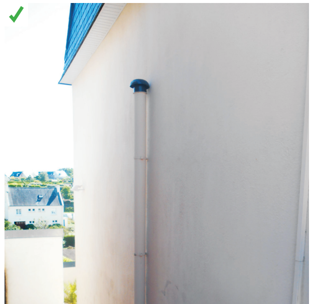
Cheminée d'évacuation adaptée. ©AQC
