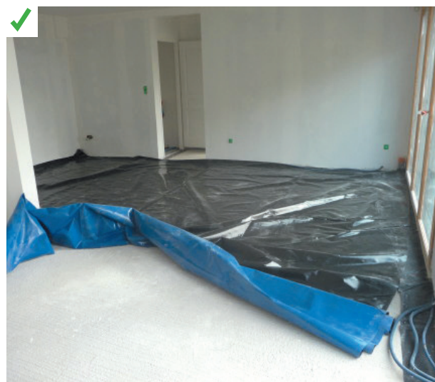
Pose de la deuxième partie de la membrane, sous la chape, une fois l'enveloppe terminée. Cette membrane est raccordée aux lés précédemment mis en œuvre sous les murs. © AQC
