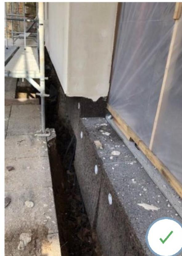
Isolation périphérique du soubassement dans le cas d'une isolation des murs par l'extérieur. ©AQC
