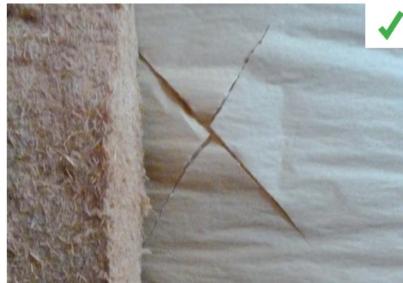
Non Qualité (à gauche) : Une couche d'isolant est appliquée en sous-face d'un surfaçage kraft.
