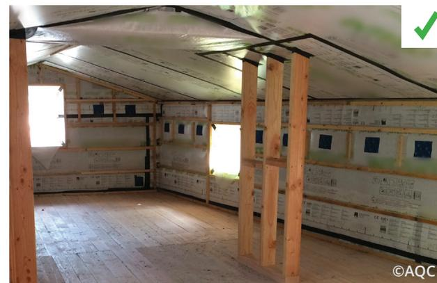
Deux façons de mettre en œuvre un plan d'étanchéité à l'air.
