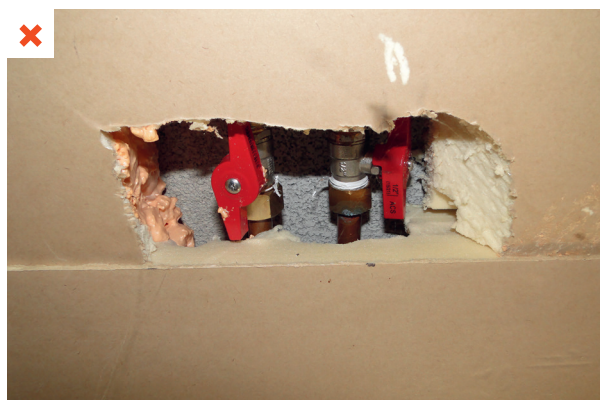
Le réseau d'eau sanitaire fixé au plafond du garage a été isolé par l'opération d'isolation de la dalle. La découpe de l'isolant pour conserver un accès aux vannes génère un important pont thermique. ©AQC
