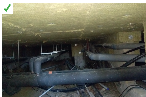
Une retombée d'isolant a été réalisée sur les refends de ce vide sanitaire. ©AQC
