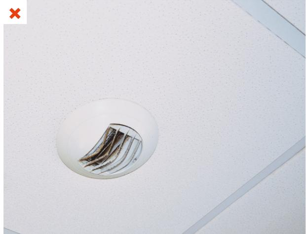
*La bouche d'extraction de l'air vicié est encrassée par les poussières. Il en résulte une baisse du débit d'extraction et un mauvais renouvellement de l'air intérieur. Bâtiment tertiaire. ©AQC*
