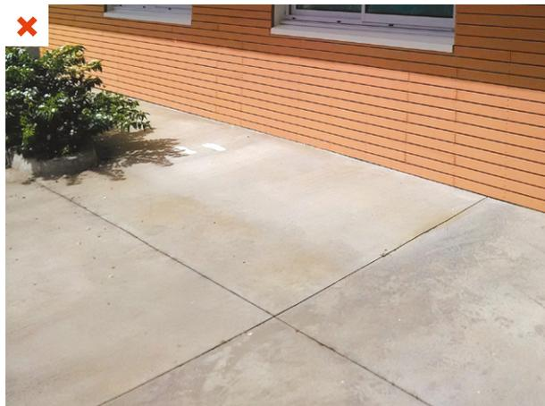
La garde de 20 cm entre le pied du bardage et le sol fini n'est pas respectée. L'air chaud ne sera pas évacué au dos du bardage. Bâtiment tertiaire. ©AQC
