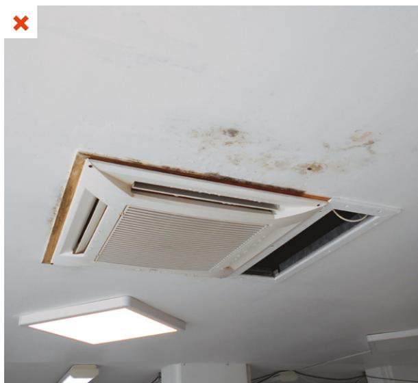
Apparition d'humidité à proximité des unités intérieures de climatisation. Bâtiment tertiaire. ©AQC
