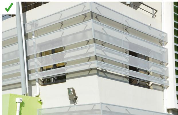
✅ Fenêtres protégées par des bandeaux métalliques perforés n'entravant ni la ventilation naturelle ni l'apport de lumière naturelle. Les occupants de ce bâtiment utilisent peu la climatisation et l'éclairage artificiel. Bâtiment tertiaire. ©AQC
