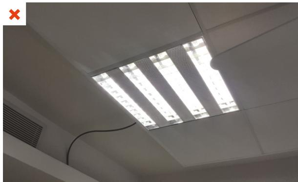
Une dalle d'éclairage a été ajoutée pour le confort visuel des utilisateurs ayant déplacé leur bureau en fond de salle. En conception, l'emplacement des bureaux avait été choisi proche des menuiseries et ne nécessitait pas d'éclairage artificiel en journée. Bâtiment tertiaire. ©AQC
