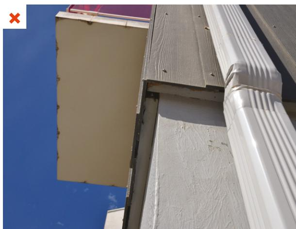
Le profilé de ventilation linéaire à âme perforée constituant la barrière antirougeurs a été substitué par un tasseau. L'évacuation de l'air chaud, accumulé au dos du bardage, n'est plus assurée. Bâtiment tertiaire. ©AQC
