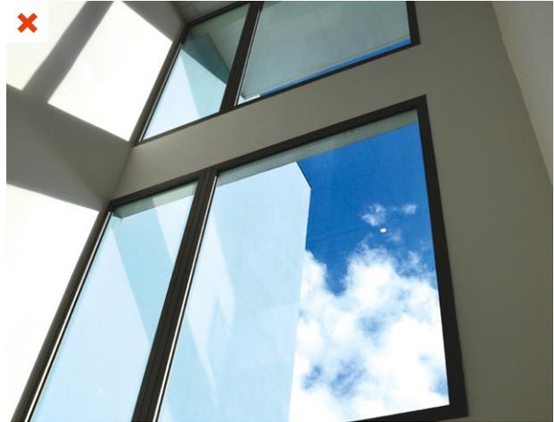
❌ Baies vitrées (orientées à l'Est) sur toute la hauteur d'un bâtiment R+2, sans protection solaire. Il en résulte une augmentation de la température intérieure et une forte gêne visuelle proche des fenêtres. Bâtiment tertiaire. ©AQC
