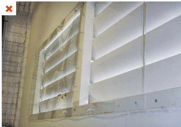
Mise en place d'une plaque de plexiglass, a posteriori, sur les ventelles d'une menuiserie, afin de réaliser l'étanchéité à l'air d'un local serveur climatisé. L'étanchéité à l'air n'est pas suffisante malgré tout. Bâtiment tertiaire. ©AQC
