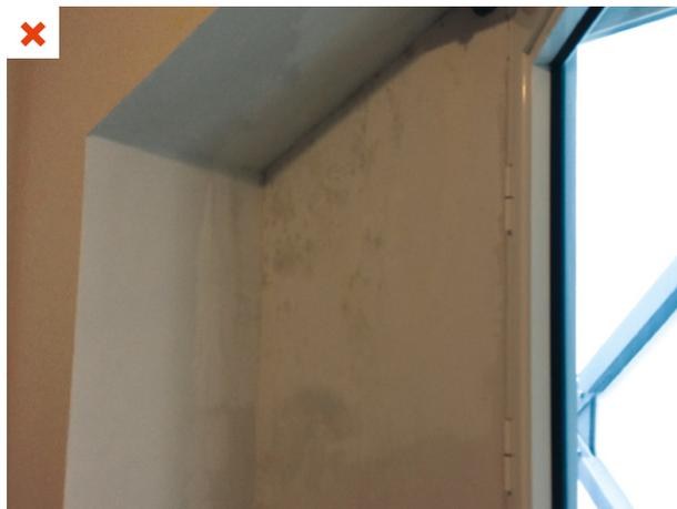
Apparition de moisissures sur la paroi isolée. La fenêtre n'est pas équipée d'entrée d'air. Bâtiment d'habitation. ©AQC
