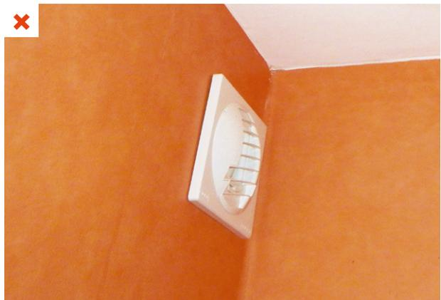
*L'emplacement de la bouche d'extraction auto-réglable, très proche du mur, ne permet pas un contrôle du débit et un entretien aisé. Logements collectifs. ©AQC*
