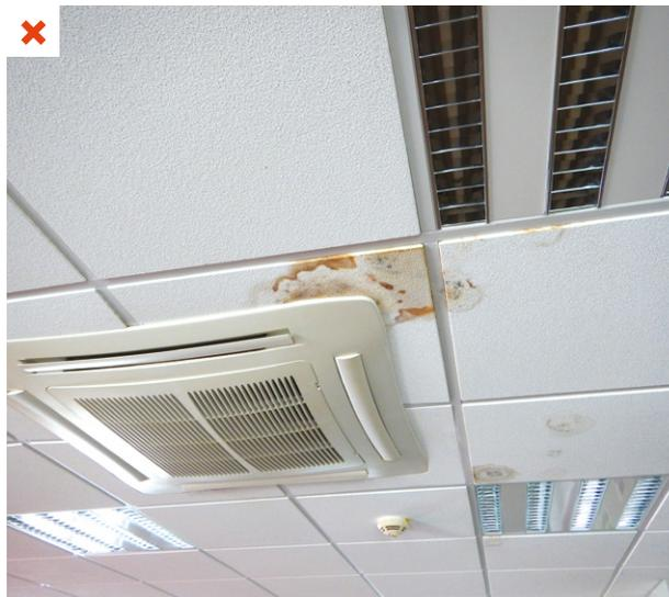
Apparition de tache d'humidité à proximité des unités intérieures de climatisation. Bâtiment tertiaire. ©AQC
