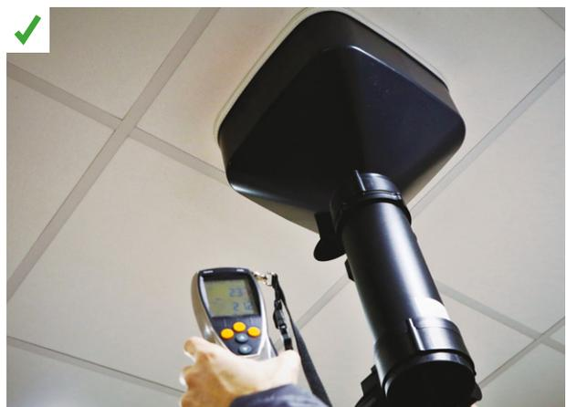
*L'emplacement des bouches d'extraction auto-réglables permet les interventions pour l'entretien et le contrôle des débits. Bâtiment tertiaire ©AQC*
