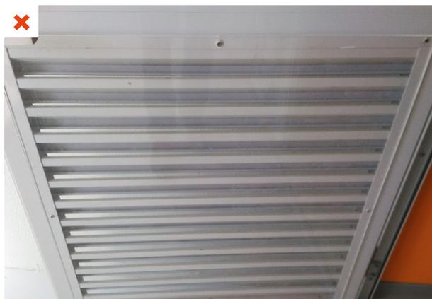
Mise en place d'une plaque de plexiglass, sur le soubassement d'une porte équipée de ventelles, pour réaliser l'étanchéité à l'air d'une salle de restauration climatisée. Des entrées d'air parasites sont toujours présentes. Bâtiment tertiaire. ©AQC
