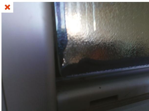
Joint d'étanchéité déformé sur une lame d'une fenêtre à jalousies. L'étanchéité à l'air n'est plus assurée. Bâtiment tertiaire. ©AQC
