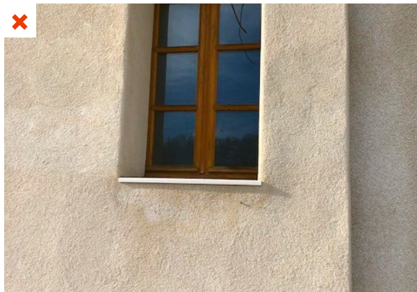
L'isolation par l'extérieur de cette maison s'arrête au niveau du mur mitoyen séparant les deux propriétés. Aucun retour d'isolant par ITI n'a été prévu sur ce mur. ©AQC
