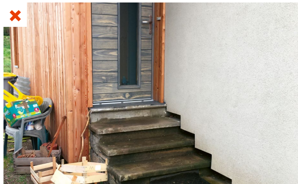
L'escalier en béton n'est pas désolidarisé de la façade isolée par l'extérieur et crée un pont thermique. ©AQC
