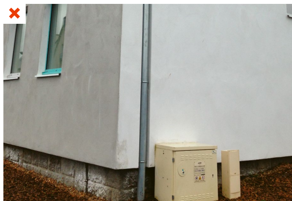
La descente d'eau pluviale n'a pas été déposée avant les travaux d'isolation, ce qui génère un important pont thermique linéaire. ©AQC
