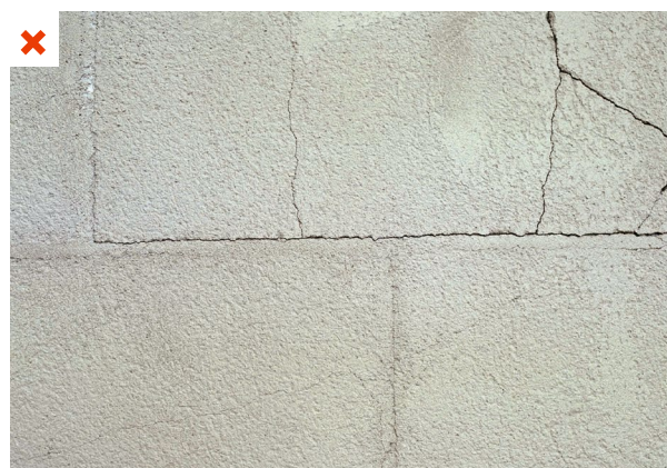
Le support de l'ITE présente des lézardes traversantes. La tenue mécanique de l'isolant par chevilles ne peut être assurée. ©AQC
