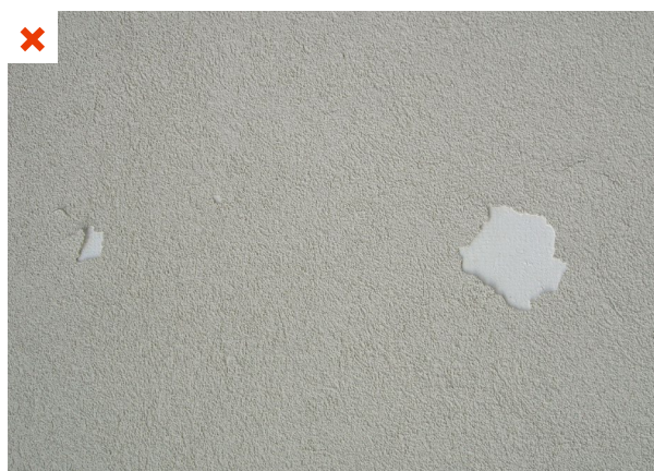
L'enduit du mur support de l'ITE se décolle. La préparation du mur par piquage n'est pas prévue. ©AQC
