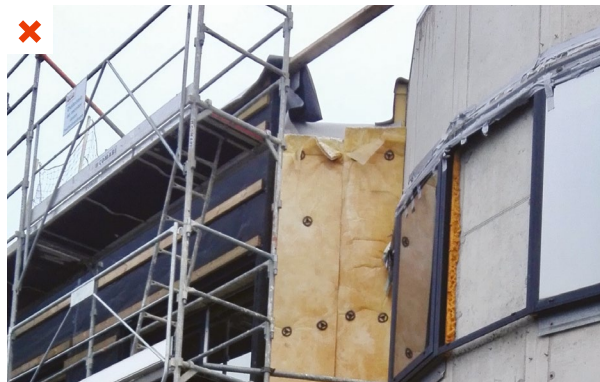
Les panneaux de laine minérale sont soumis à la pluie et au vent. Les panneaux en haut de façade se dégradent fortement.
