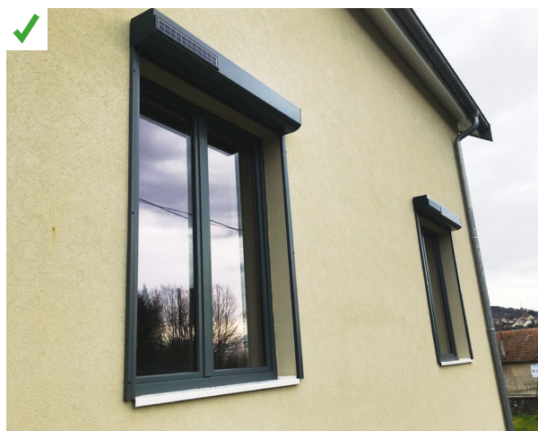
Les volets roulants sont fixés au nu extérieur de l'ITE avec des accessoires adaptés. Le pont thermique est ainsi évité. ©AQC
