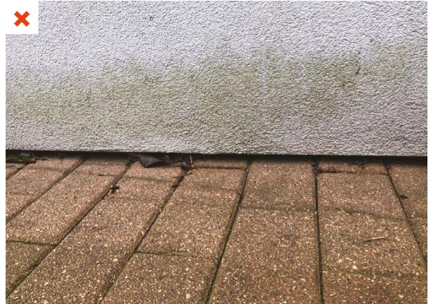
⚠ Développement de mousse et de moisissures sur une ITE en pied de façade du fait du rejaillissement de l'eau depuis les pavés. ©AQC
