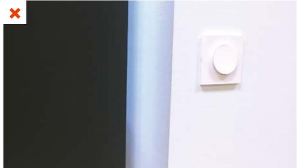
La gradation manuelle s'effectue par un appui long sur l'interrupteur. Ce n'est pas intuitif pour certains usagers qui ne s'en servent donc pas. L'éclairage est toujours allumé à pleine puissance. ©AQC
