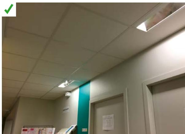
Tubes fluorescents équipés de réflecteurs dans une circulation. Une partie de la lumière est issue de la réflexion et limite les impacts de la lumière directe. ©AQC
