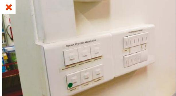
L'ensemble de l'éclairage est commandé par des interrupteurs situés à un seul et même endroit du bâtiment. Les lumières fonctionnent en tout ou rien. Il n'existe pas de système de détection malgré la présence de sectorisation. ©AQQC
