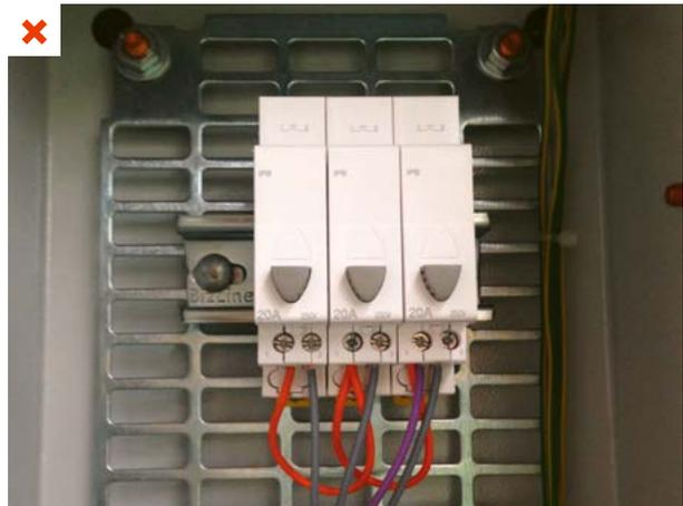
Les différents niveaux de gradation (30 %, 50 % et 100 %) de l'éclairage de la salle de sport sont manuels et les interrupteurs se trouvent dans un boîtier électrique. Aucune information sur l'utilisation n'est fournie. ©AQC
