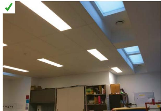
L'éclairage artificiel est piloté grâce au protocole DALI. Différents scénarii sont mis en place selon les classes. ©AQQC
