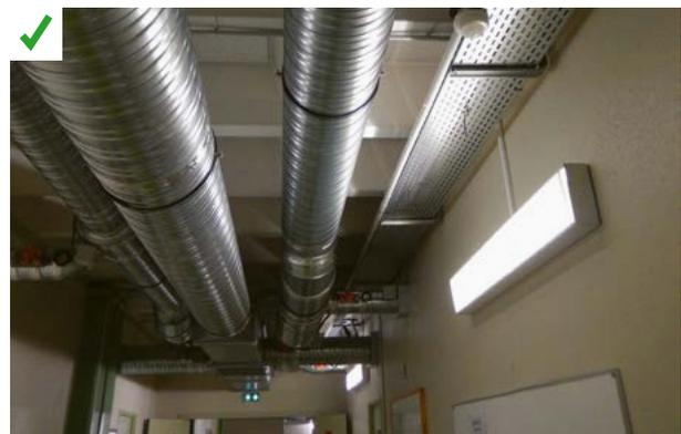
Lors d'une opération de relamping, le luminaire composé de tubes fluorescents a été entièrement remplacé par un luminaire LED. Le relamping a également été l'occasion d'un changement de positionnement du luminaire sur le mur pour qu'il ne soit pas impacté par les réseaux en plafond. ©AQC
