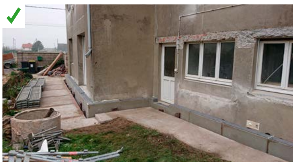
Les dalles ciment de la terrasse sont enlevées sur une largeur d'environ 40 cm, ce qui permet de décaisser le pourtour de la maison et d'isoler le soubassement. ©AQC
