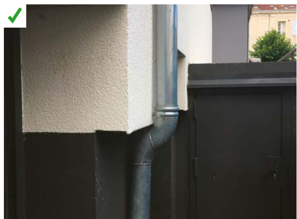
La descente d'eau pluviale a été déposée, puis refixée sur la façade. Un coude de raccordement en bas d'ITE permet une connexion au collecteur des eaux pluviales. ©AQC
