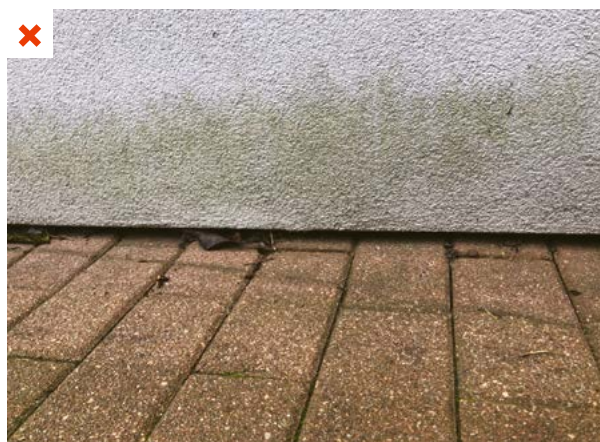
Développement de mousse et de moisissures sur une ITE en pied de façade du fait du rejaillissement de l'eau depuis les pavés. ©AQC
