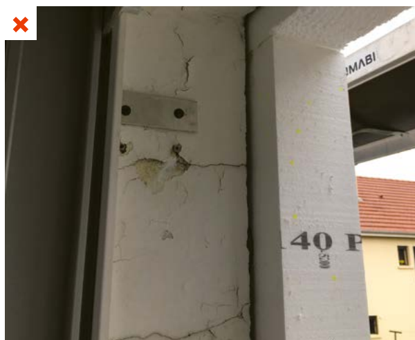
Le revêtement du tableau de fenêtre présente des décollements importants et des lézardes. Or l'isolant en polystyrène est fixé uniquement par collage à cet emplacement. ©AQC
