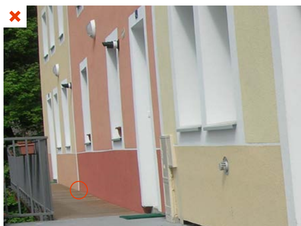
L'ITE descend à fleur du balcon. ©AQC
