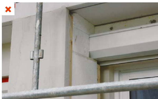
Pont thermique sur toute la longueur du coffre de volet roulant et maintenance impossible sans démontage localisé de l'ITE en appui du coffre. ©AQC
