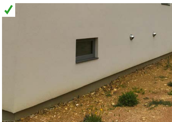
Départ de l'ITE à 15 cm minimum du sol. L'isolation des parties enterrées est assurée par du verre cellulaire. ©AQC
