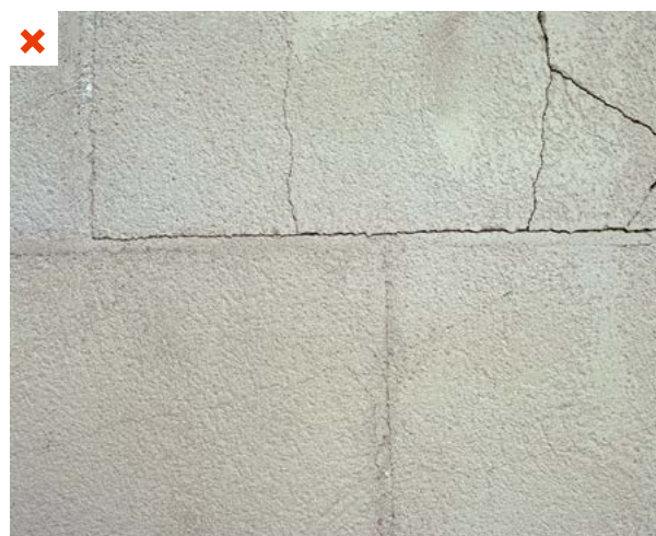
Le support de l'ITE présente des lézardes traversantes. La tenue mécanique de l'isolant par chevilles ne peut être assurée. ©AQC
