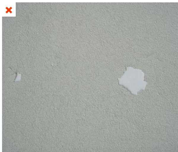
L'enduit du mur support de l'ITE se décolle. La préparation du mur par piquage n'est pas prévue. ©AQC
