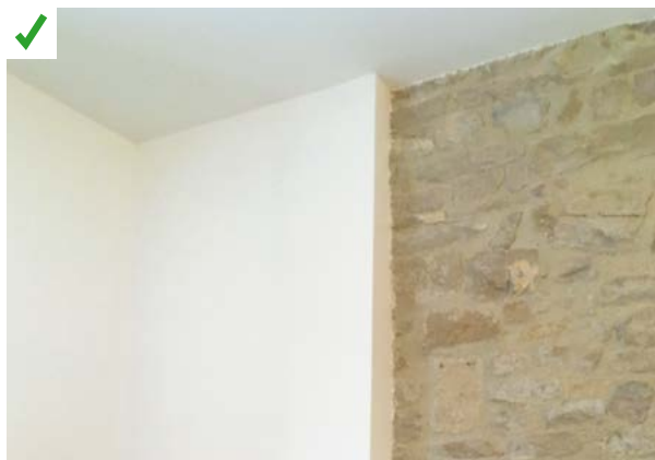
Pour des raisons esthétiques et/ou patrimoniales, le mur de façade de cette maison en pierre est isolé par l'intérieur, alors que les autres murs le sont par l'extérieur. Un retour d'isolant est mis en œuvre et assure le traitement du pont thermique. ©AQC
