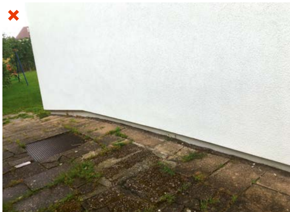
L'absence d'isolation des soubassements crée un pont thermique au niveau de la dalle basse. ©AQC
