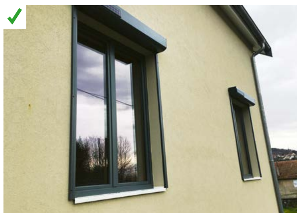
Les volets roulants sont fixés au nu extérieur de l'ITE avec des accessoires adaptés. Le pont thermique est ainsi évité. ©AQC
