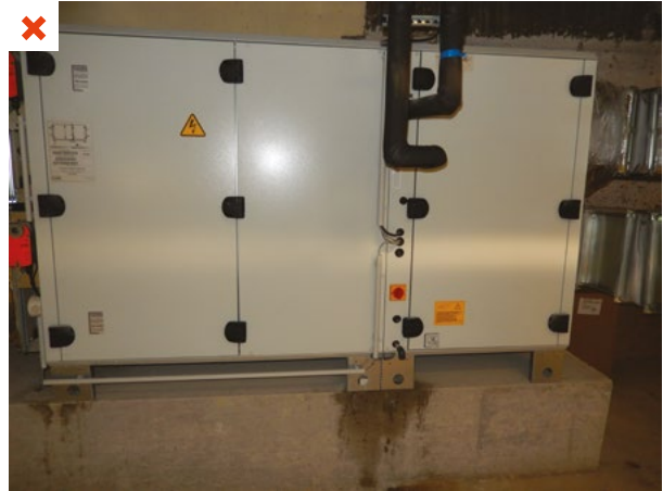
Sur cette CTA, l'évacuation des condensats n'a pas été raccordée au réseau EU ou EP, ce qui engendre de l'humidité sous la CTA. ©AQC
