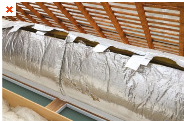
Sur cette gaine située en volume non chauffé, le calorifugeage est déficient sur toute la longueur. Ceci entraîne des déperditions. ©AQC
