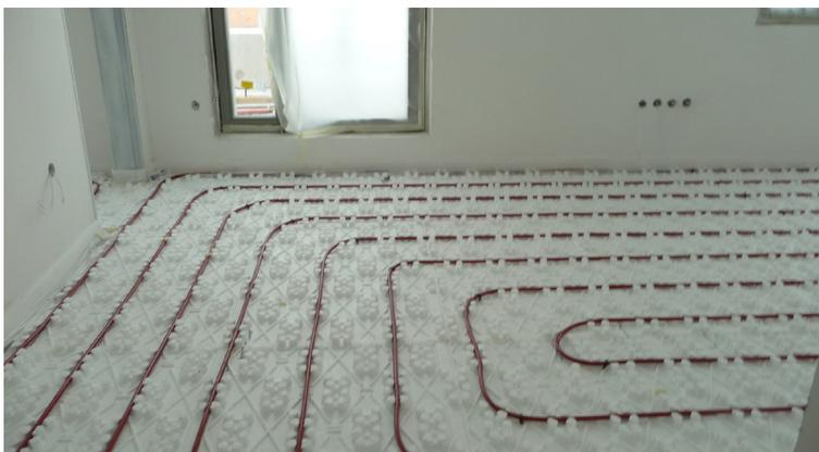
Illustration 13 - Le radiateur à eau standard est l'émetteur le plus souvent installé dans les bâtiments du panel, mais les planchers chauffants répondent au fonctionnement basse température et les radiateurs électriques aux faibles besoins
