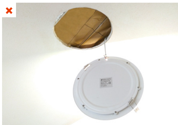
L'isolant, en panneaux revêtus d'un surfacage Kraft et classé inflammable, est en contact direct avec le spot encastré. ©AQC
