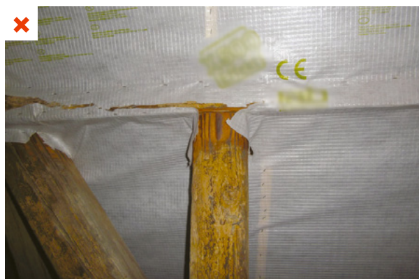
La membrane est déchirée au droit des éléments de charpente la traversant. Elle n'est fixée que par des agrafes. Aucune reprise n'a été effectuée. ©AQC
