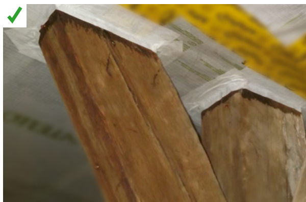
Un primaire d'accrochage a été appliqué sur les pièces de bois pour une meilleure adhérence de l'adhésif. ©AQC
