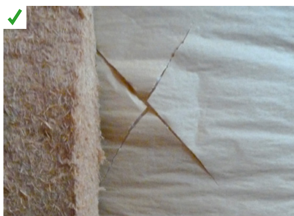
En cours de chantier, des fentes ont été réalisées de façon régulière sur le pare-vapeur existant avant la mise en place des panneaux isolants. ©S.Courgey
