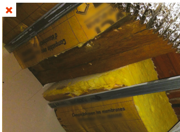
L'isolant est plaqué contre les liteaux. Aucune lame d'air n'est présente en sous-face de la couverture en tuiles. ©AQC
