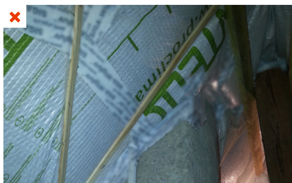
L'isolation et la membrane d'étanchéité à l'air sont en contact direct avec le conduit de cheminée maçonné. ©AQC
