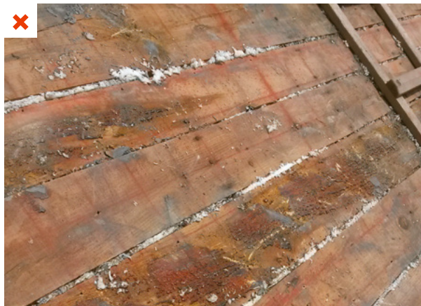
Absence de lame d'air. L'isolant est au contact du voligeage. ©AQC
