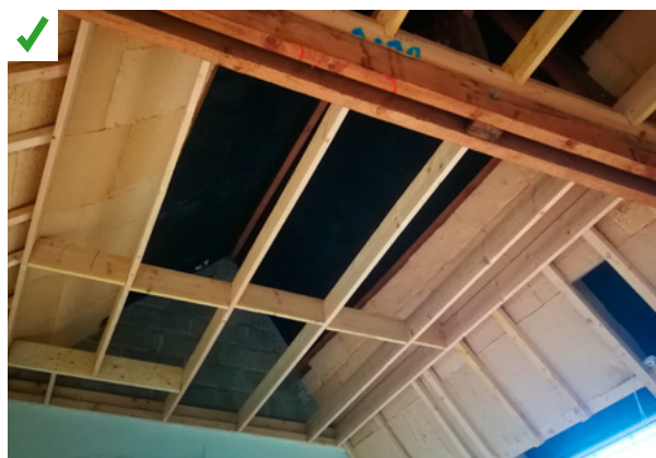
Grâce à des découpes précises et soignées, les panneaux de fibre de bois sont positionnés entre chevrons sans laisser d'espaces vides. La densité des panneaux participe également à leur bonne tenue. Une seconde épaisseur d'isolant en couche croisée sera mise en œuvre avant la pose de l'étanchéité à l'air.
