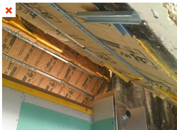
Les extrémités des panneaux isolant ploient sous leur propre poids, notamment au faîtage à la jonction entre les deux pans de toiture. ©M.Auriac
