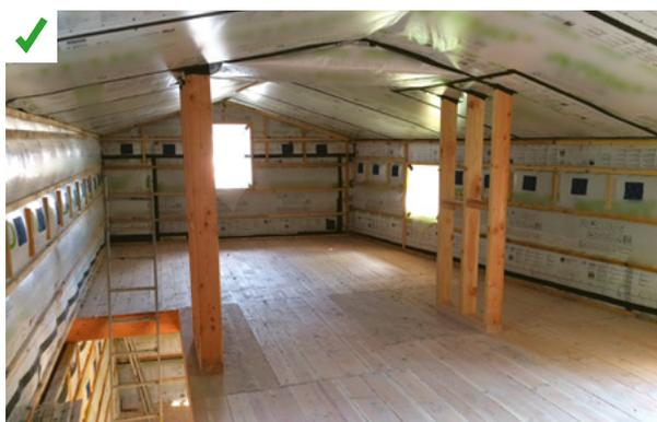
Le plan d'étanchéité à l'air, réalisé à l'aide d'une membrane et de l'adhésif prévus à cet effet, est continu. Un contre tasseautage sera apporté ultérieurement pour obtenir un vide technique et fixer le parement intérieur. ©AQC
