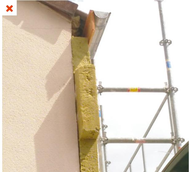
L'isolation des rampants par l'intérieur ne se raccorde pas avec l'isolation de la façade à ce point de jonction. Un pont thermique linéique très important est créé.
