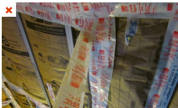
Le surfaçage kraft est considéré à tort comme une membrane d'étanchéité à l'air. La jonction des panneaux est réalisée par du ruban adhésif posé par-dessus les fourrures. Ces deux points ne permettent pas de bénéficier d'une continuité du plan d'étanchéité à l'air. ©AQC
