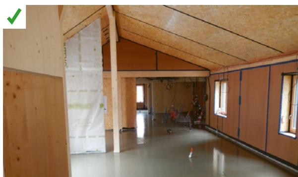
Le plan d'étanchéité à l'air, réalisé à l'aide de panneaux OSB jointés par de l'adhésif prévu à cet effet, est continu. ©AQC
