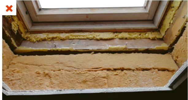
La jonction entre la menuiserie et le chevêtre est assurée par de la mousse expansive. Des vides sont présents entre les panneaux isolants et le chevêtre, ce qui crée un pont thermique. N.B. : Il existe en outre un problème de continuité de l'étanchéité à l'air avec le dormant. ©AQC
