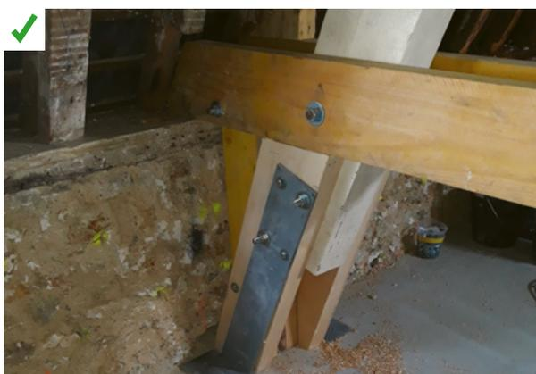
Le chantier a commencé par la mise hors d'eau et un temps de séchage du bâtiment de plusieurs mois avant le lancement des travaux. La charpente existante a été consolidée. ©F. Petetin
