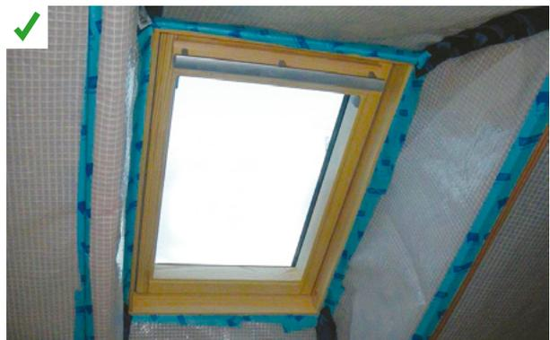
L'interface entre la fenêtre de toit et les rampants est isolée et étanche à l'air. ©AQC
