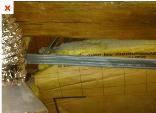
L'isolation est appliquée en une seule couche entre pannes. Des suspentes métalliques sont utilisées pour fixer les fourrures et maintenir l'isolant. Les pannes et les suspentes métalliques traversent le complexe isolant de part en part, créant des ponts thermiques dits intégrés. ©AQOC
