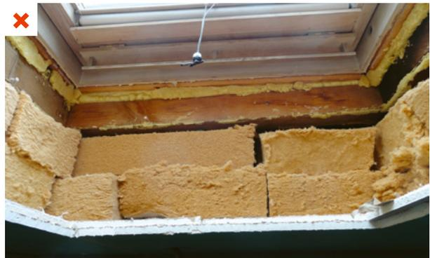
Le pourtour de la fenêtre de toit a été isolé avec des chutes de panneaux d'isolant, ce qui ne permet pas la continuité de l'isolation. ©AQC
