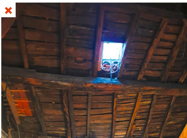
Au fil des années, la vétusté de la charpente a conduit au flambage des pannes intermédiaires. Cependant, aucune reprise même partielle de la charpente n'est prévue dans le cadre de la rénovation. ©AQC
