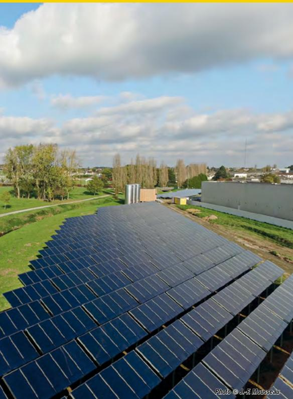
▲ Centrale solaire thermique de Châteaubriant (44) : 200 capteurs plans double vitrage, 2 340 m<sup>2</sup> utiles, inclinaison 30°, stockage 150 m<sup>3</sup> en 3 ballons, mise en service en juin 2018.
