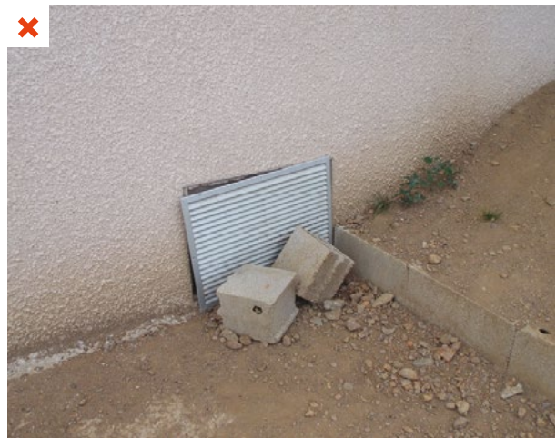
La prise d'air de la ventilation double flux est située au niveau du sol dans une cour de récréation. La poussière mise en suspension lors des jeux des enfants encrasse très rapidement les filtres de la CTA. ©AQC
