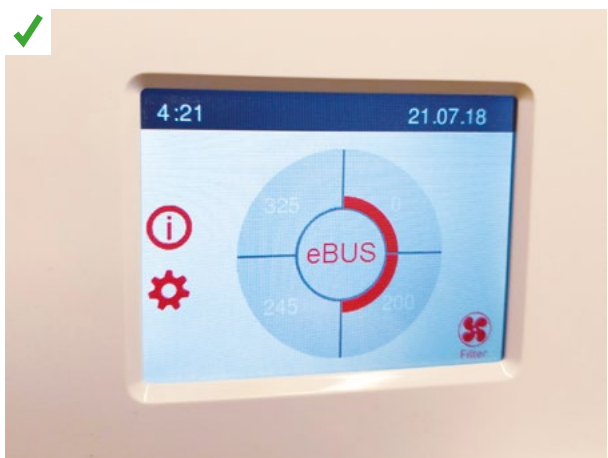
L'écran permet la remontée d'information en direct de l'état du filtre et avertit quand le changement doit s'effectuer. ©AQC
