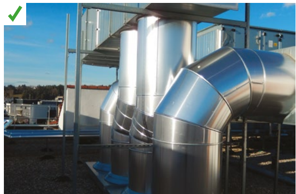
Le calorifugeage des gaines est en double peau donc protégé des UV, des intempéries et des oiseaux, assurant une pérennité dans la performance thermique du système. Les longueurs de gaines en extérieur sont relativement courtes. ©AQC
