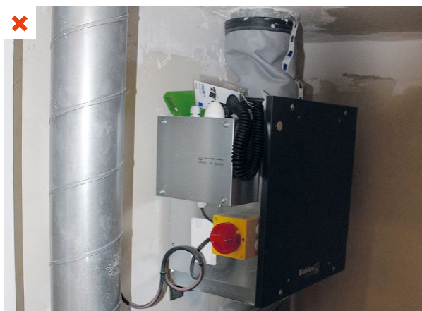
Le caisson simple flux est directement fixé sur le mur et n'est pas désolidarisé. ©AQC
