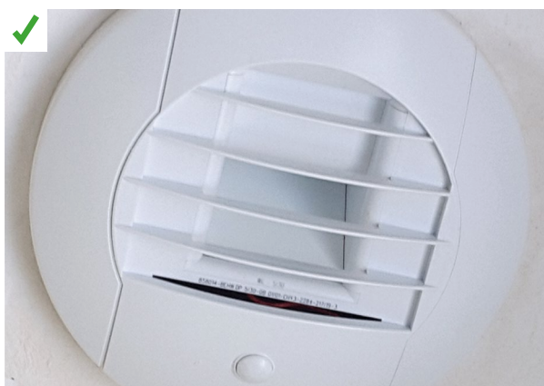
Cette bouche d'extraction a été nettoyée et ne présente aucune poussière ni salissure. ©AQC
