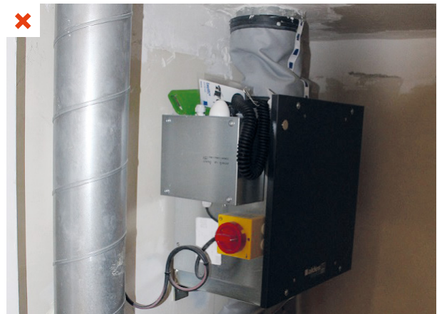
Le caisson simple flux est directement fixé sur le mur et n'est pas désolidarisé. ©AQC
